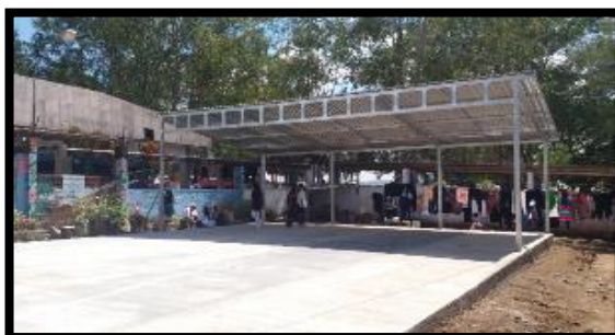
Construcción de Cancha
