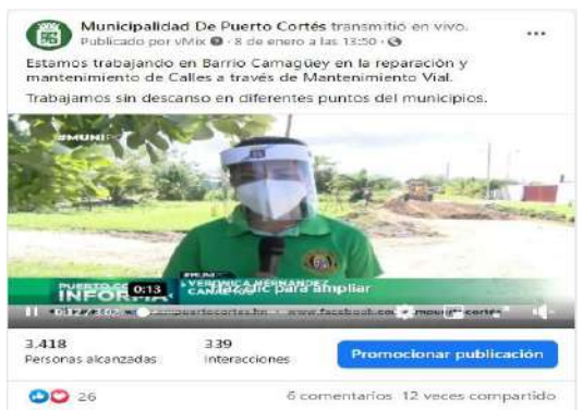
Reparación de calle en Camagüey
