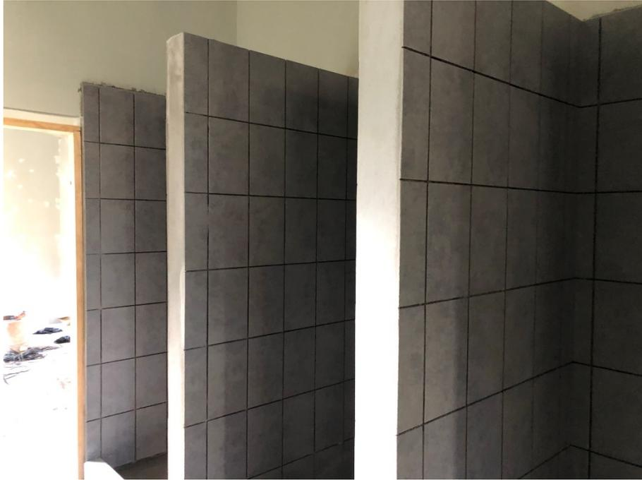
Imagen 12. Instalación de cerámica en baño.
