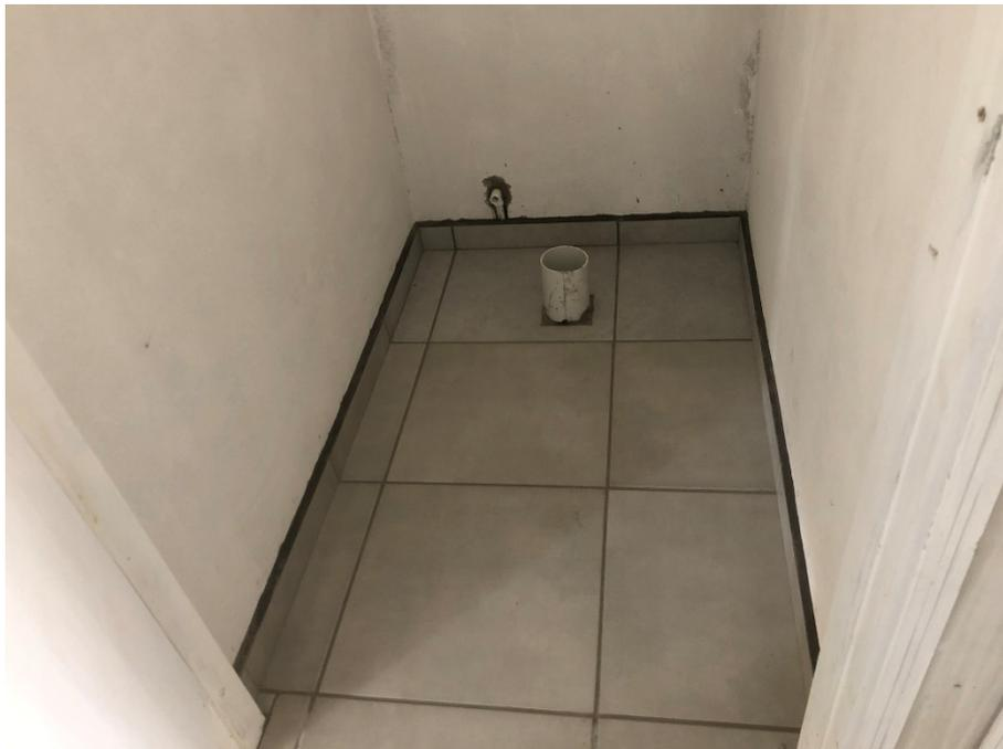
Imagen 1. Instalación de Tuberías de 4”.
