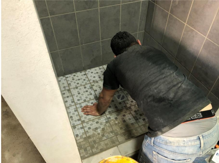
Imagen 11. Instalación de cerámica en baño
