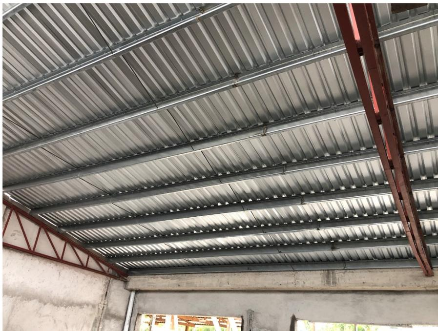
Imagen 7. Instalación de techo y cerchas metálicas – Módulo I
