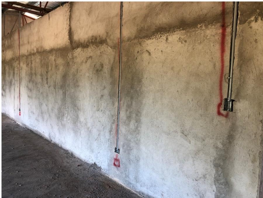
Imagen 10. Instalación de cajas para interruptores y tomacorrientes – Módulo I
