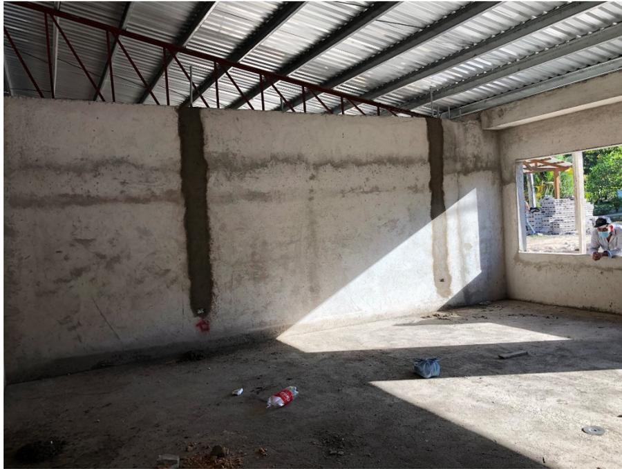
Imagen 9. Instalación de cajas para interruptores y tomacorrientes – Módulo I
