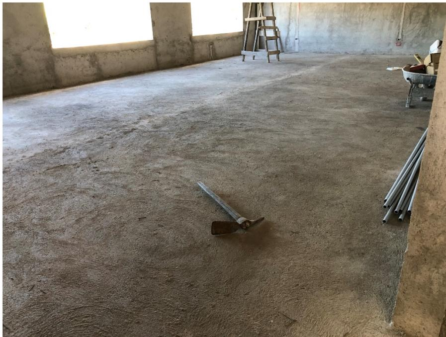
Imagen 6. Fundición de Firme de Concreto – Módulo I
