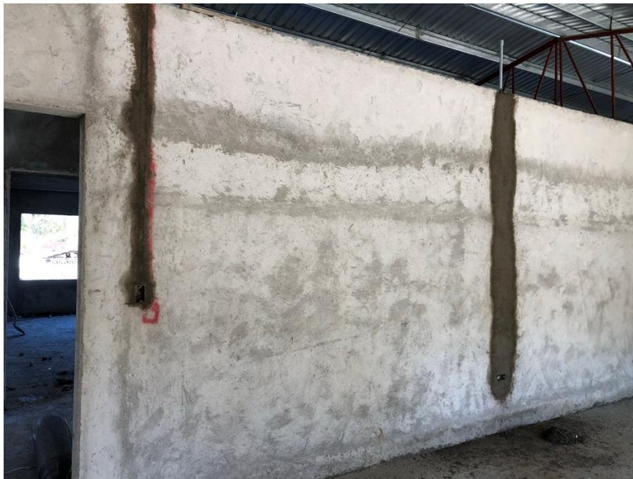
Imagen 8. Instalación de cajas para interruptores y tomacorrientes – Módulo I
