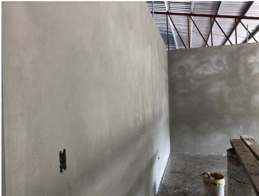
Imagen 12. Pulido de Paredes – Módulo I
