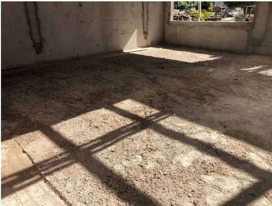
Imagen 5. Compactado de Material Selecto – Módulo I
