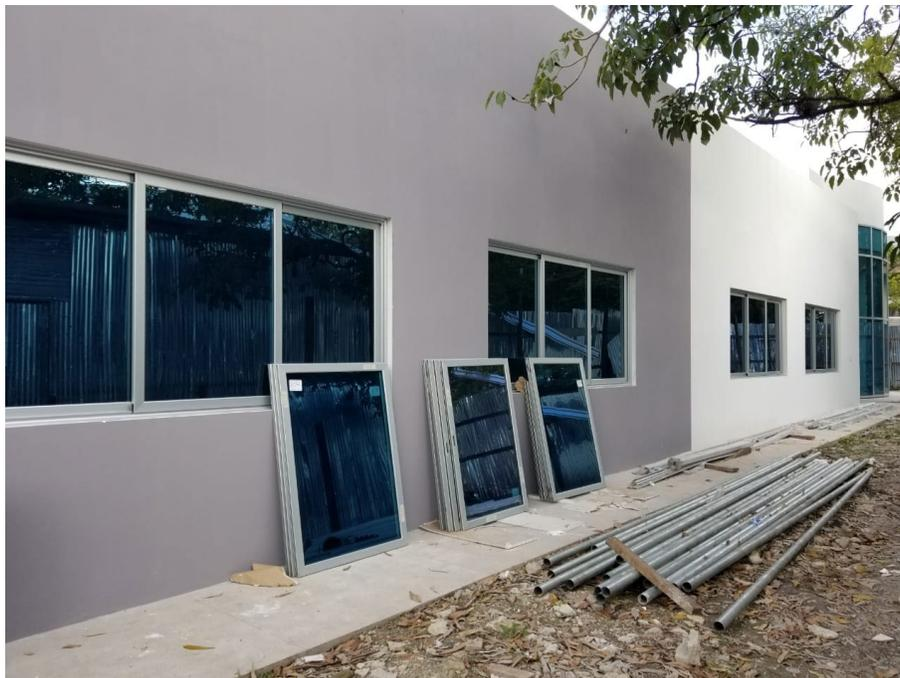
Imagen 3. Instalación de Ventanas – Módulo III
