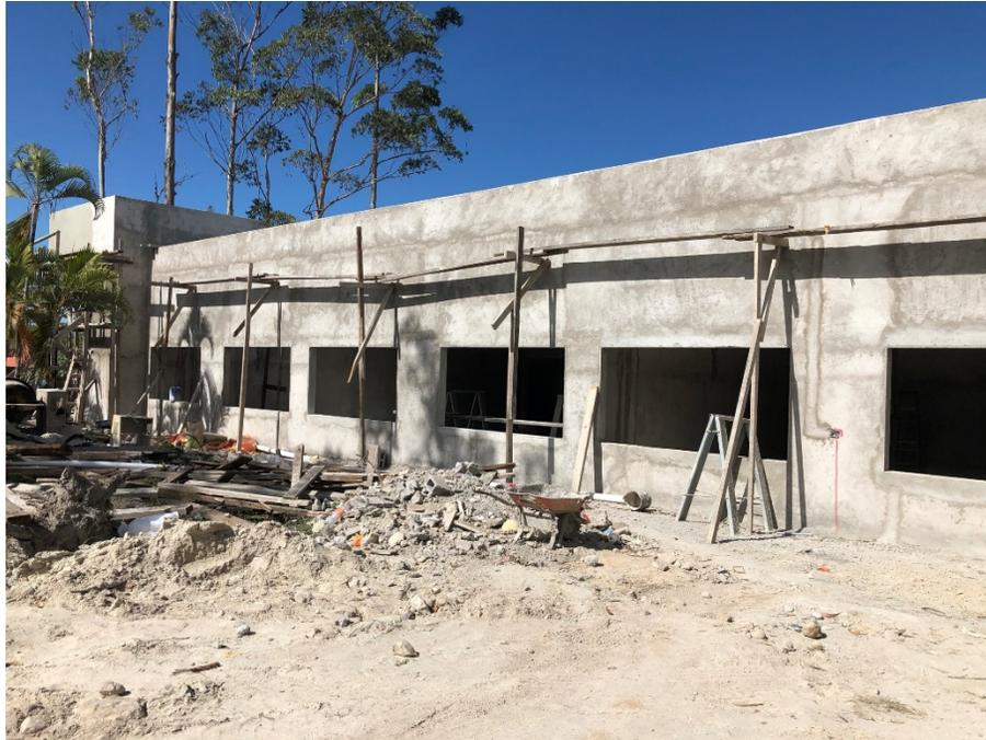
Imagen 11. Repello de Paredes – Módulo I
