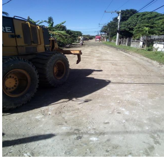
Reparación de calles B° El Retiro
