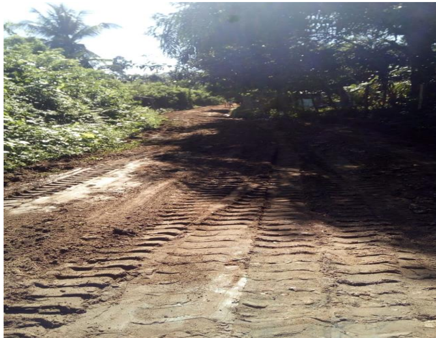
Reparación de calles en Piedras Gordas
