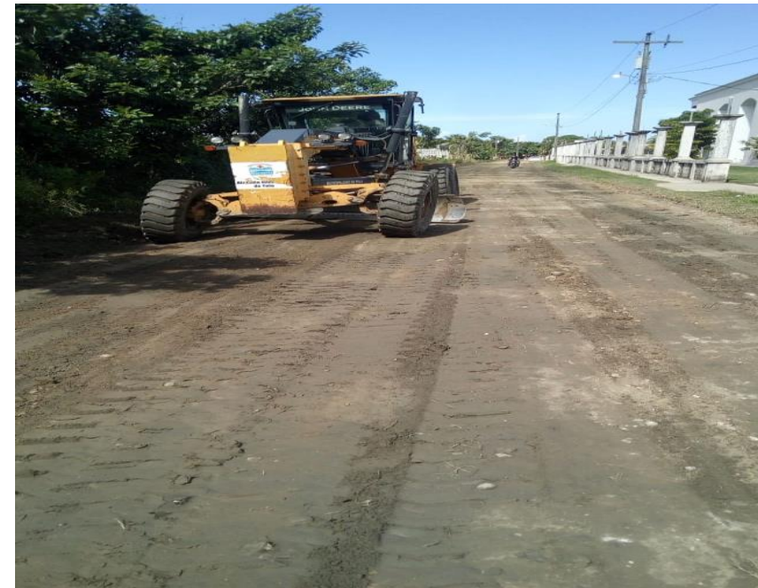
Reparación de calles B° Las Lomas
