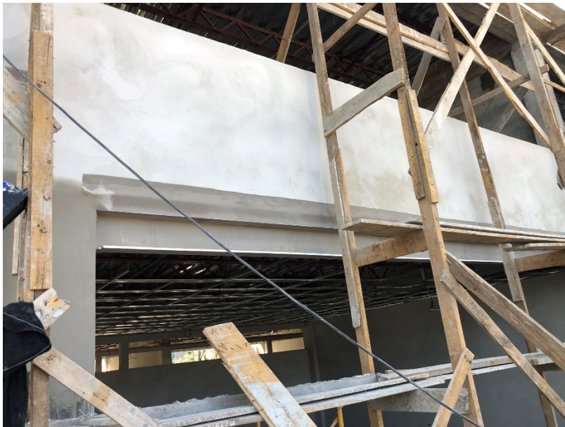
Imagen 3. Instalación de Fascias de Durock en exteriores.
