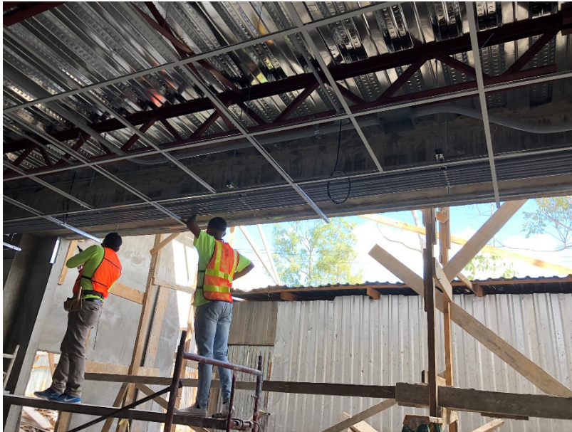
Imagen 2. Instalación de Fascias en Ventanas
