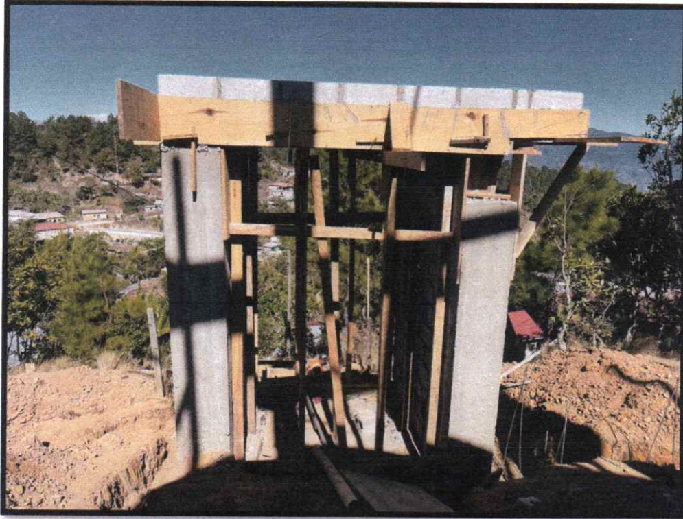
Acceso secundario 02 paredes y losa
