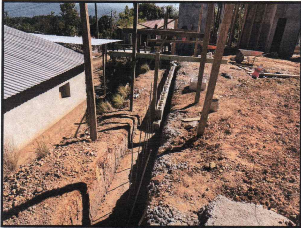
Cimentaciones de muro perimetral en la parte Noreste
