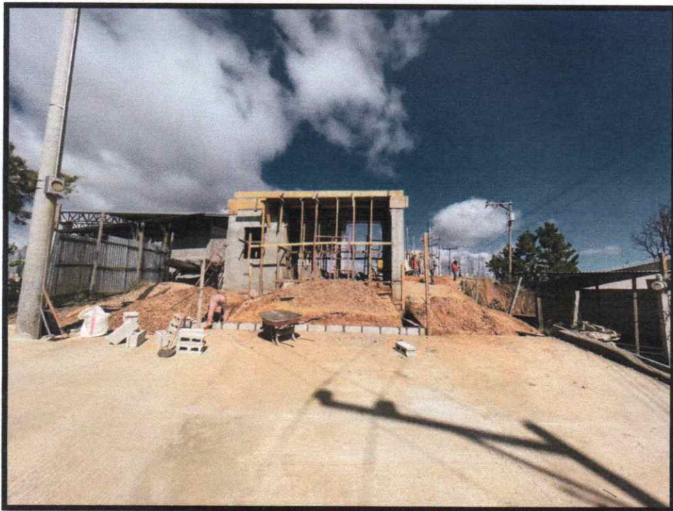
Paredes de acceso secundario 01.
