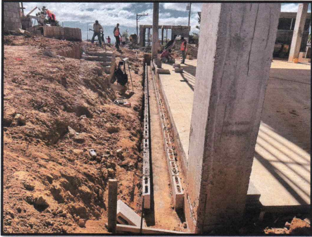
Cuneta de drenaje en la parte Noreste.
