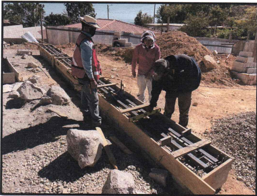
Cimentación para base de letras.
