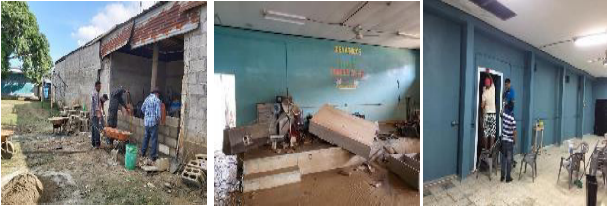
Actividades de limpieza y reparación realizadas
