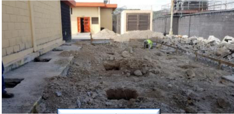
Obra en ejecución de Celdas
