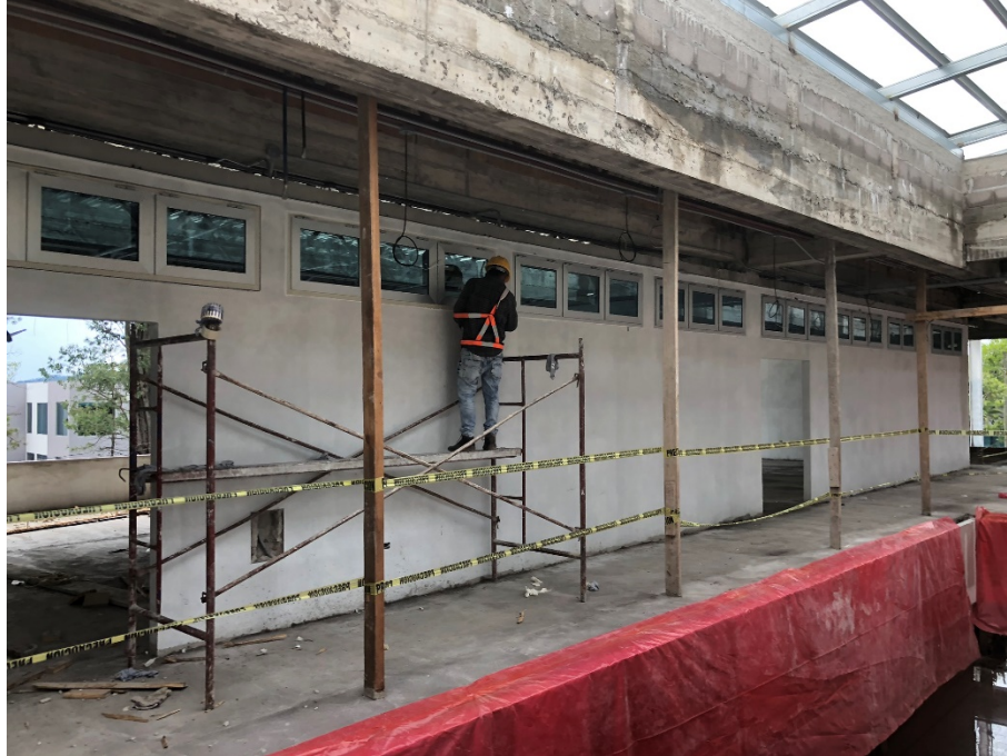
Imagen 9. Ventanas de marco de aluminio y vidrio en aulas
