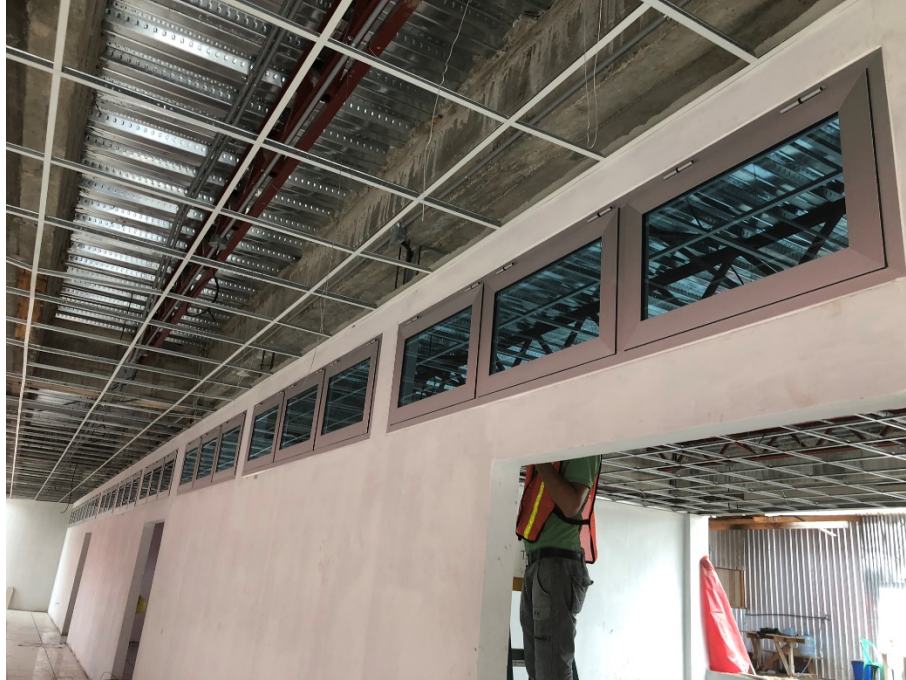
Imagen 7. Ventanas de marco de aluminio y vidrio en aulas
