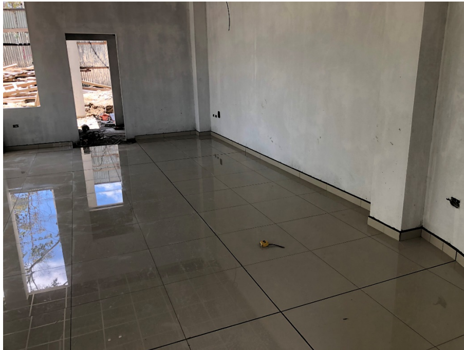
Imagen 4. Instalación de Zócalo
