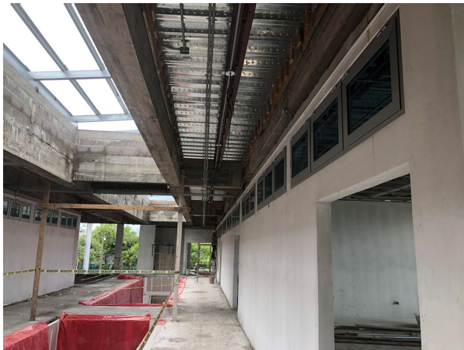
Imagen 8. Ventanas de marco de aluminio y vidrio en aulas
