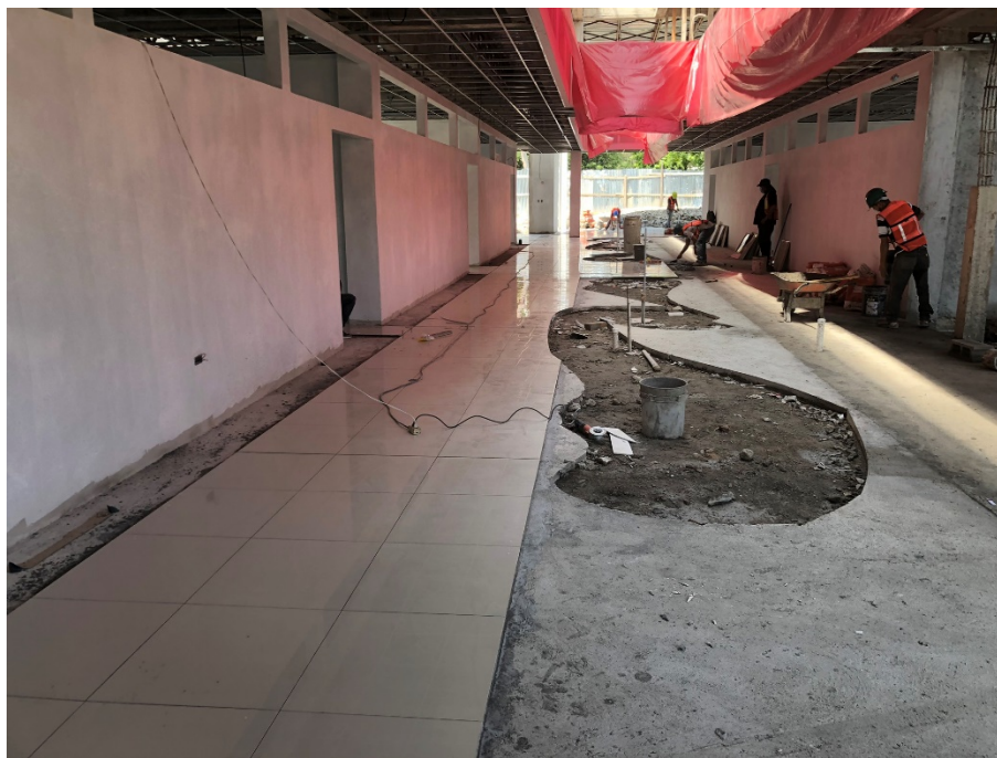
Imagen 6. Sellador en paredes internas
