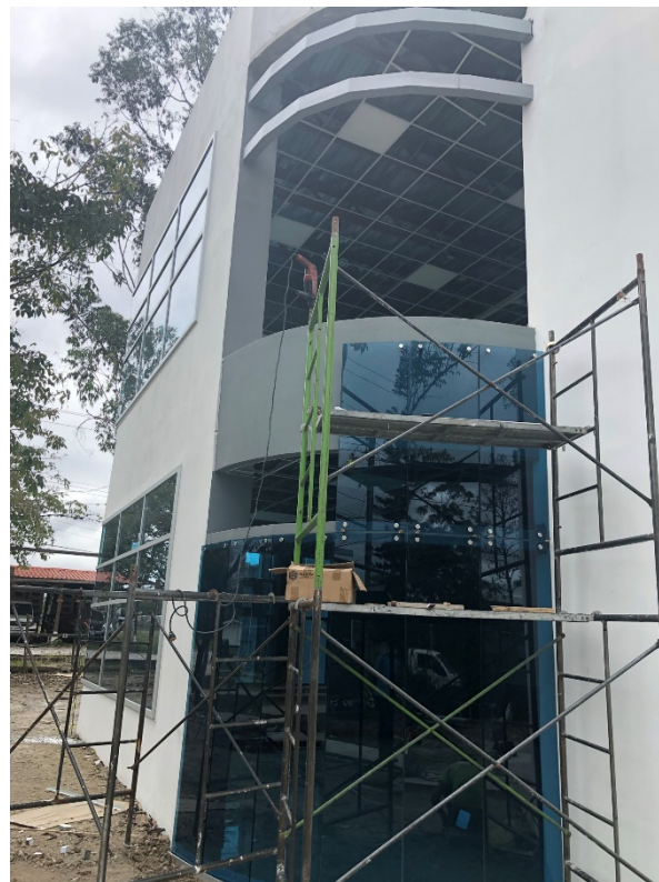
Imagen 3. Instalación de muros cortinas tipo araña.
