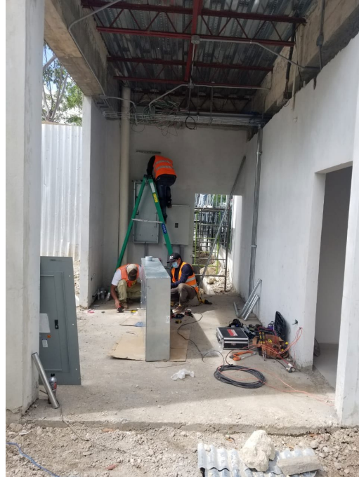
Imagen 10. Paneles eléctricos
