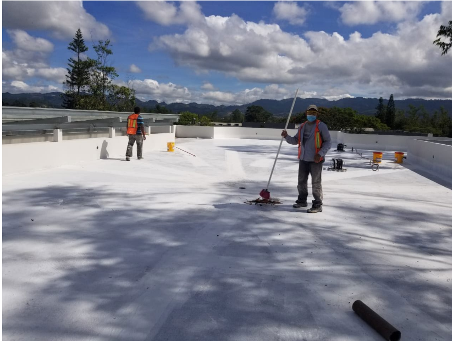
Imagen 8. Impermeabilización de losa.
