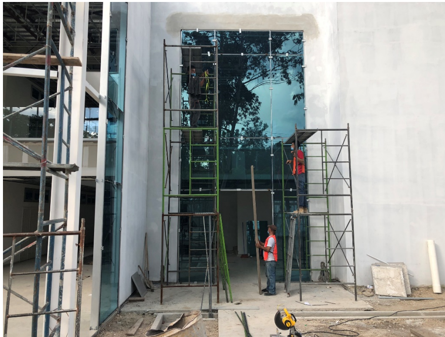
Imagen 1. Instalación de muros cortinas trasero
