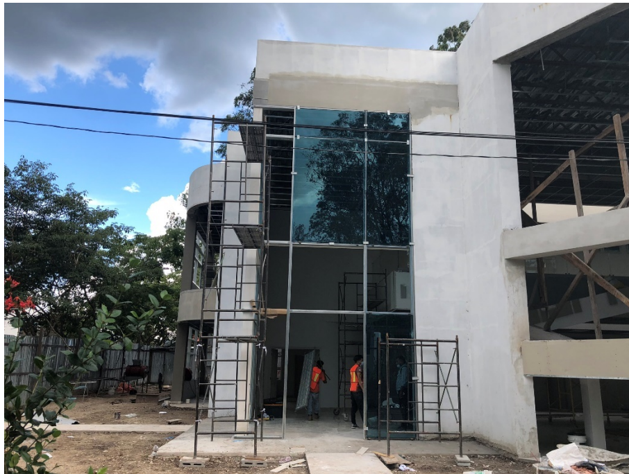
Imagen 3. Instalación de muros cortinas frontal
