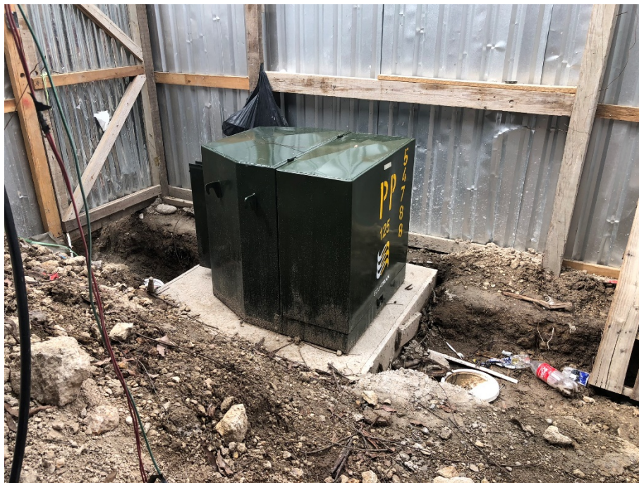
Imagen 13. Transformador.
