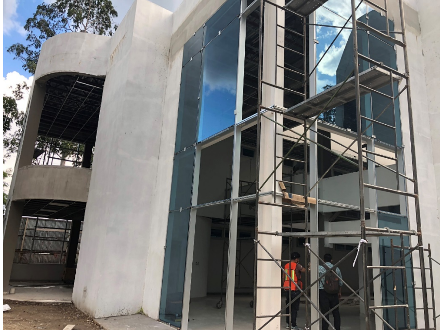
Imagen 4. Instalación de muros cortinas frontal.
