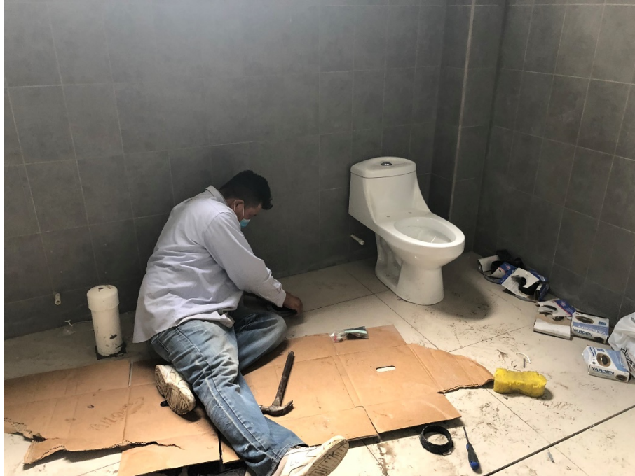
Imagen 15. Instalación de Sanitarios
