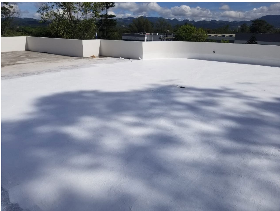
Imagen 7. Impermeabilización de losa.
