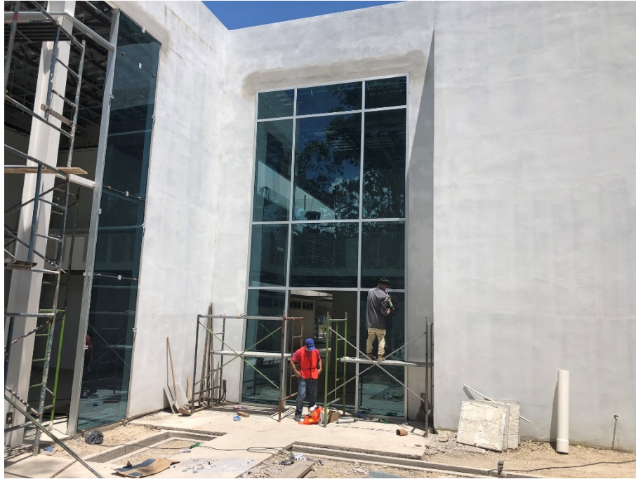
Imagen 2. Instalación de muros cortinas trasero
