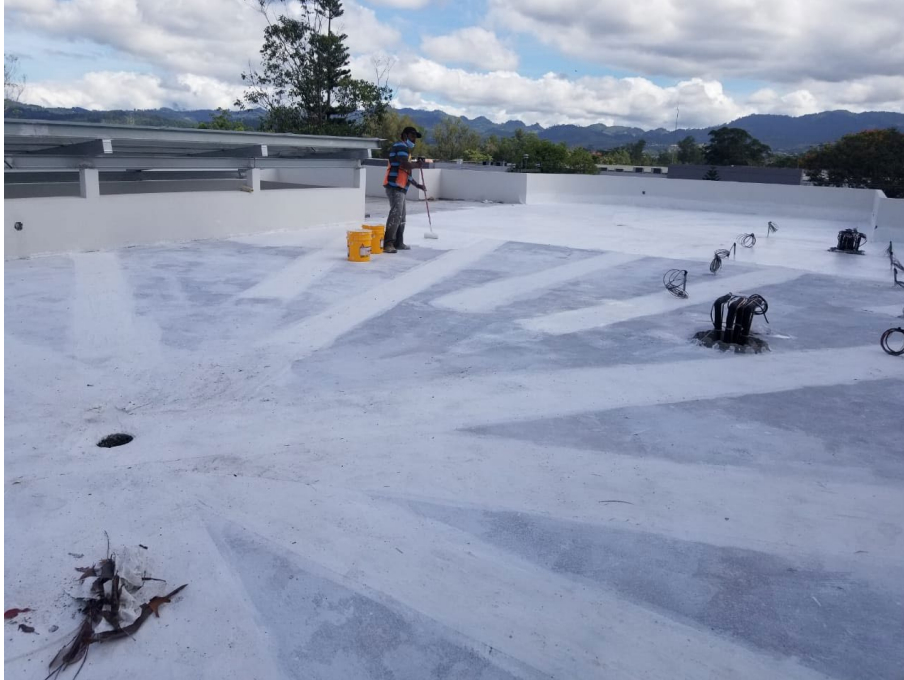
Imagen 6. Impermeabilización de losa.
