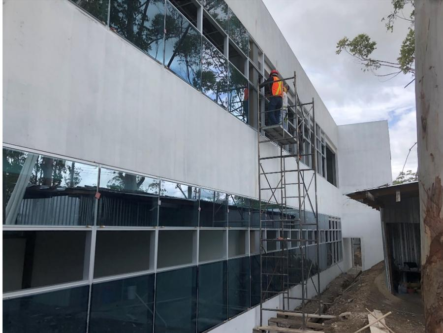
*Imagen 5. Instalación de muros cortinas laterales*
