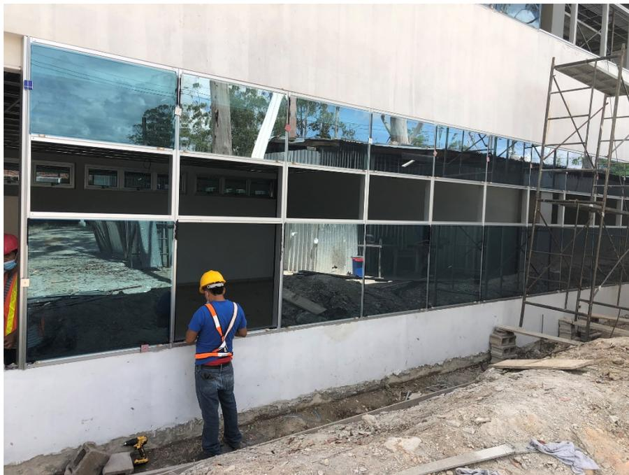
*Imagen 6. Instalación de muros cortinas laterales*
