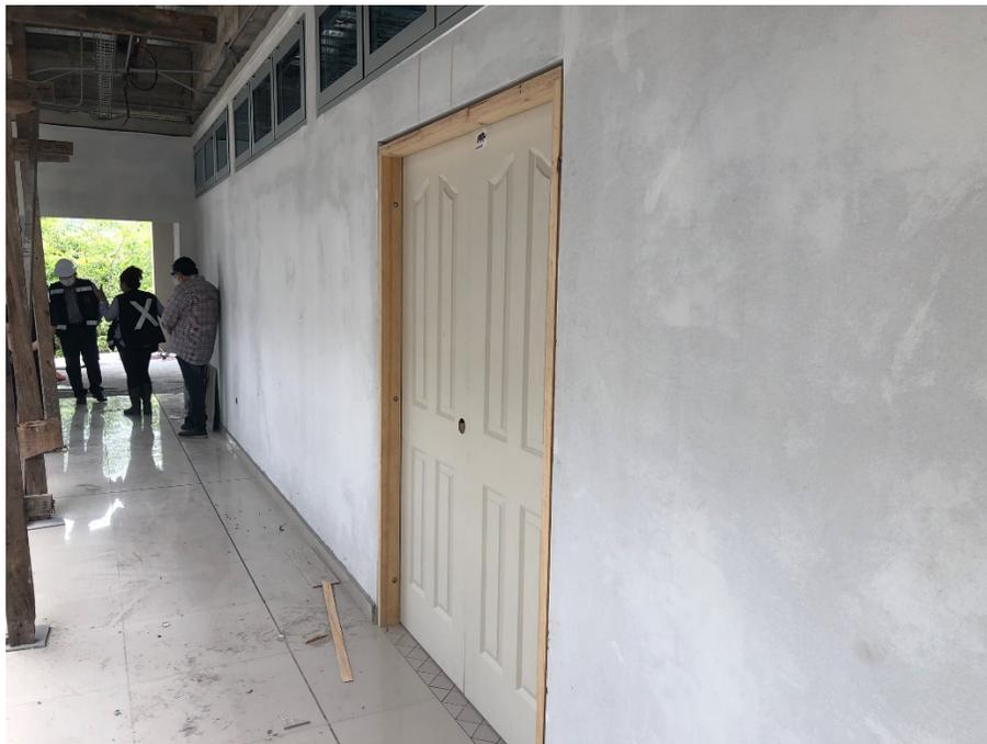
*Imagen 8. Instalación de puertas termoformadas*
