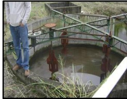
**Figura 6: Tanque Mezclador y de Inoculación**
