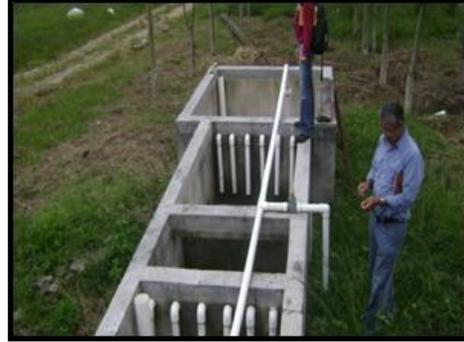
**Figura 4: Sedimentador de Aguas Residuales**
