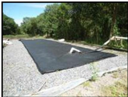
**Figura 7: Geotubo sobre filtro de arena**
