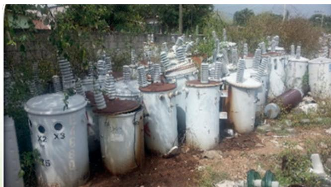
Fotografía 6. Subestación de Comayagua, conjunto de Transformadores eléctricos expuestos a la intemperie.
