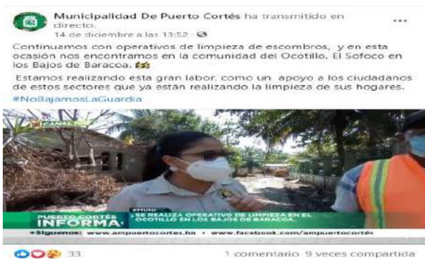
Limpieza de escombros en el Ocotillo
