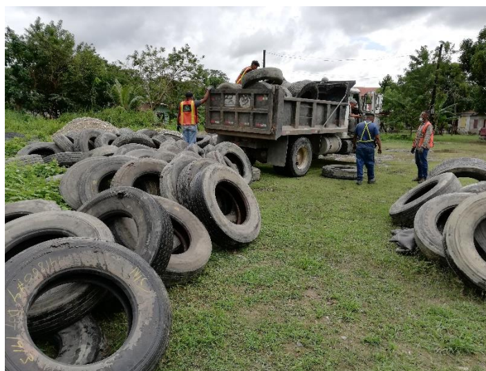
Figura 2: Traslado de llantas para estabilizar suelo en Bo. El Porvenir
