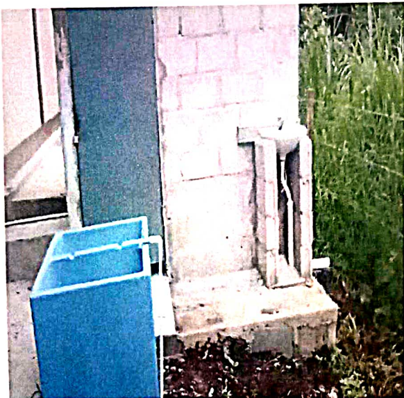
Instalación de pila y lavamanos
