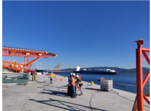
Área central ya fundida (enero 2020).
