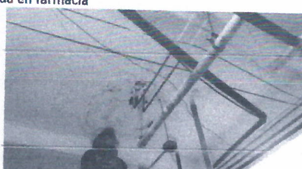
Reparaciones de fugas, tuberías dañadas, cambios de tramos de cobre a PVC.
