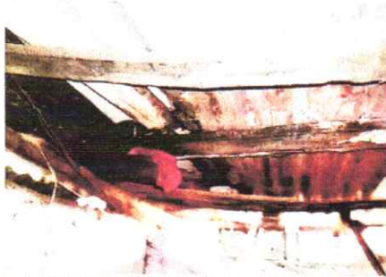
Fig. 8 y Fig.9. Se evidencia el material defectuoso con el cual está construida la estructura del techo que sostiene tejas de barro que generan un peso considerable sobre la misma. Las filtraciones de agua a través del techo van provocando daños en las paredes de la vivienda.
