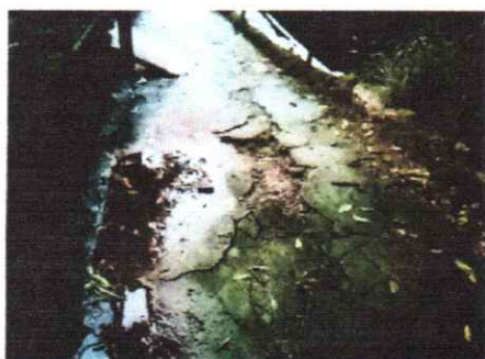
Fig. 13 y Fig. 14. Podemos observar el daño que ha sufrido el pasillo que está sobre el talud y que permite la filtración de agua al mismo, acelerando el proceso de meteorización y provocando deslizamientos juntamente con las acción de fracturamiento por parte de las raíces de los árboles.
