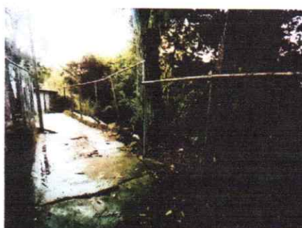
Fig. 13 y Fig. 14. Podemos observar el daño que ha sufrido el pasillo que está sobre el talud y que permite la filtración de agua al mismo, acelerando el proceso de meteorización y provocando deslizamientos juntamente con las acción de fracturamiento por parte de las raíces de los árboles.
