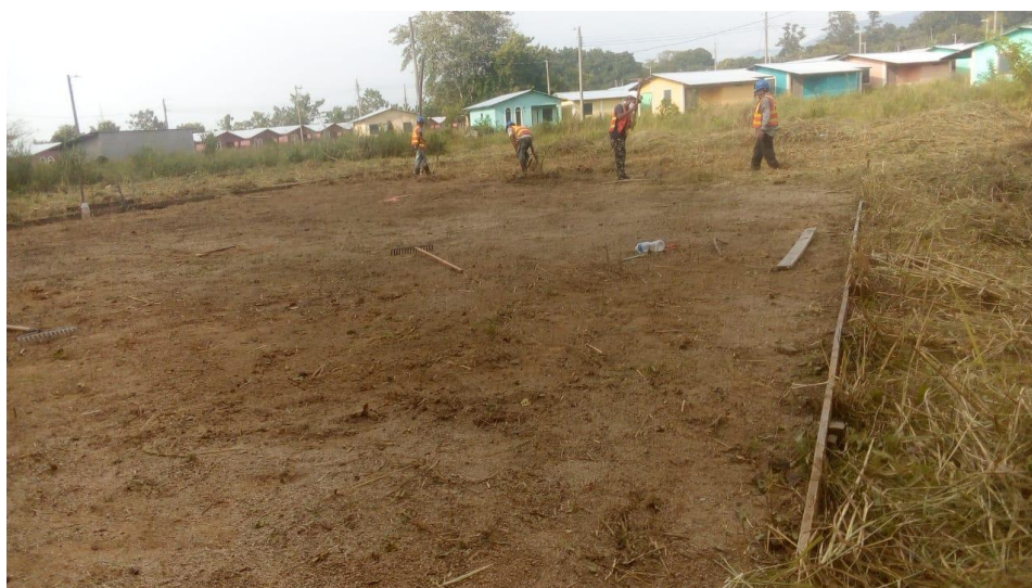
Descapotado de área de terreno donde se construye el “Parque para Una Vida Mejor”
