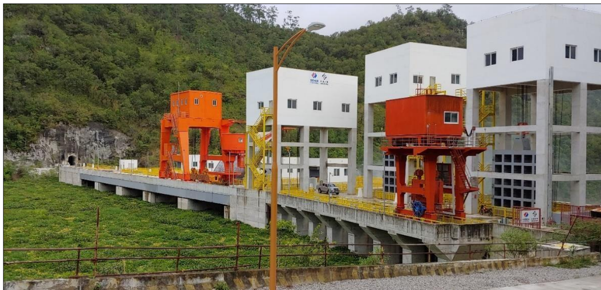
GRUA DE LA CRESTA Y GRÚA DE LAS REJILLAS DE LIMPIEZA.
