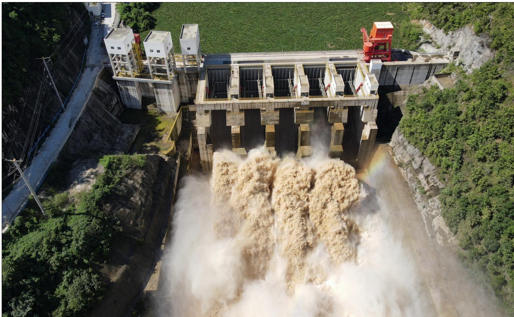
Vista aérea aguas arriba de la descarga controlada en el Sitio de Presa.
