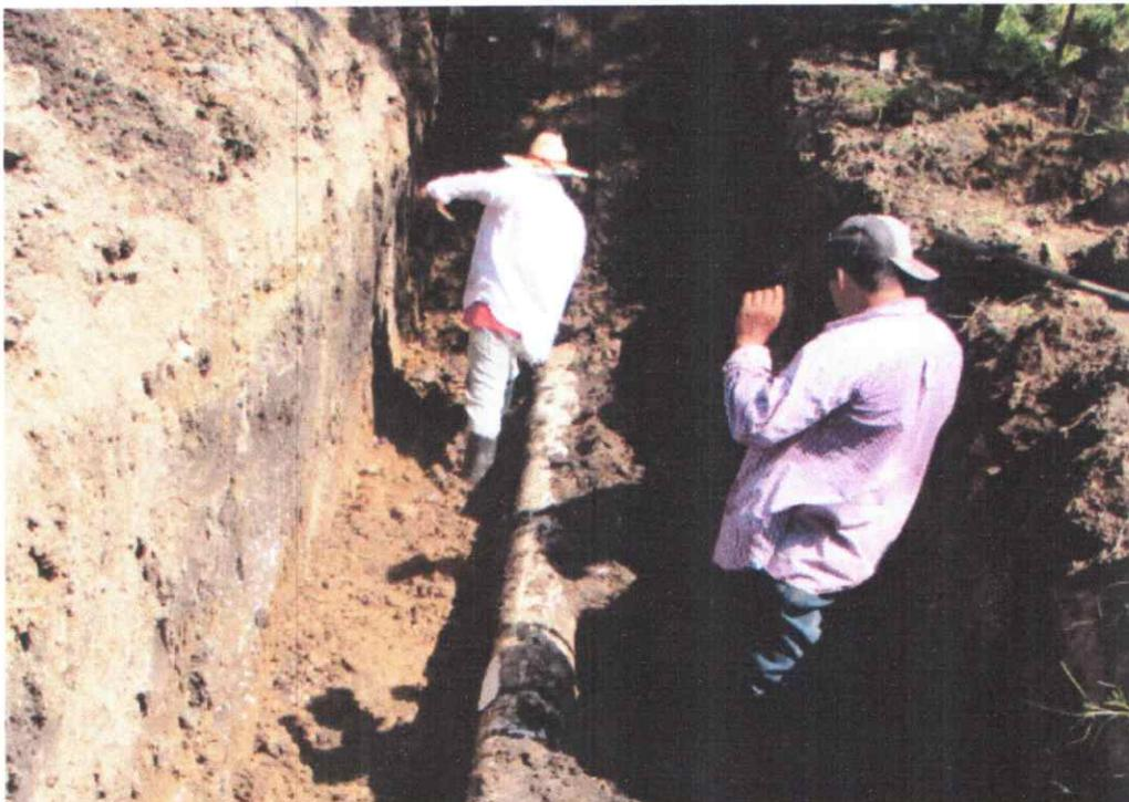
8. Reparación de tubería de impulsión de 6" en Col. Orquídea I.
