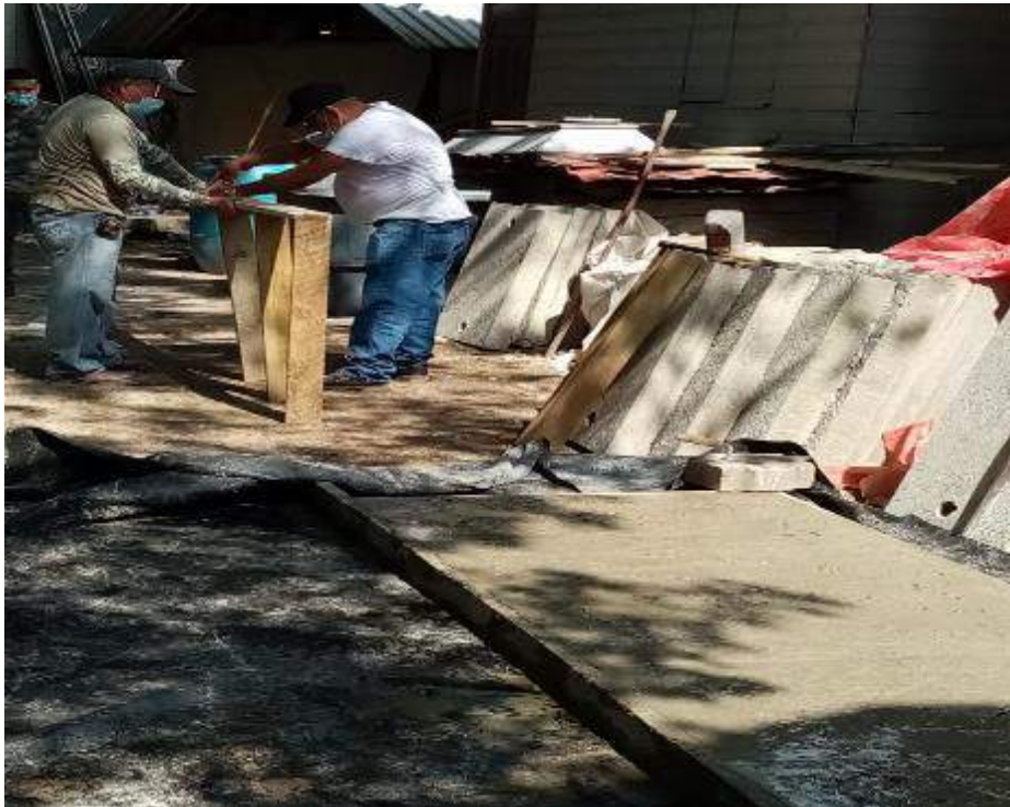
Fundición de tapaderas, Taller de Mantenimiento.
