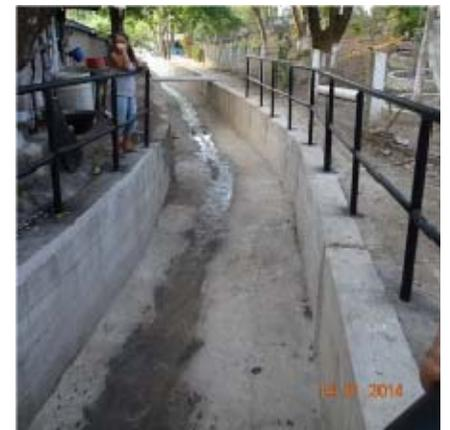
ILUSTRACIÓN 24: IMÁGENES DE LA CONSTRUCCIÓN DE CANALIZACIÓN DE AGUAS PLUVIALES DE POTRERILLOS, CORTES
