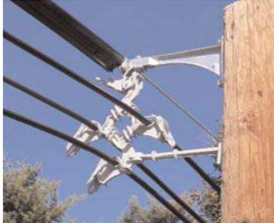
A continuación, se muestra un detalle ilustrativo para los herrajes a utilizar en el cable mensajero.
