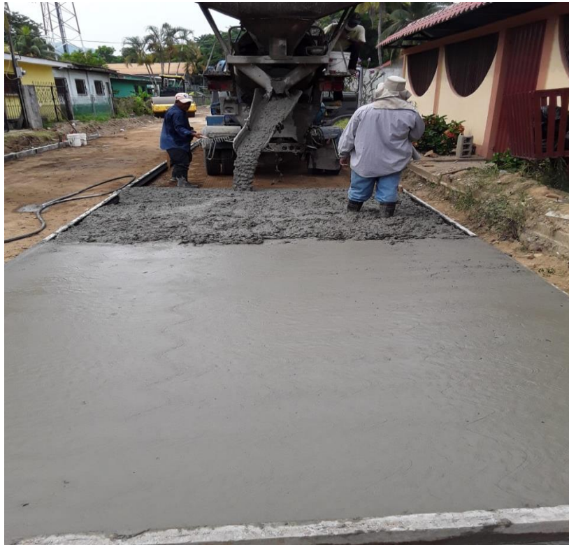
Ilustracion1. Fundición de losa de pavimento.
