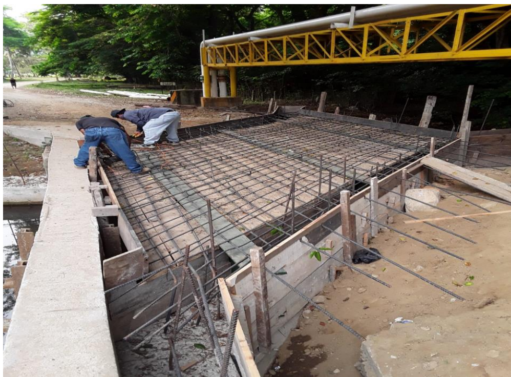
Ilustracion3. Armado de acero para losa del puente #1.
