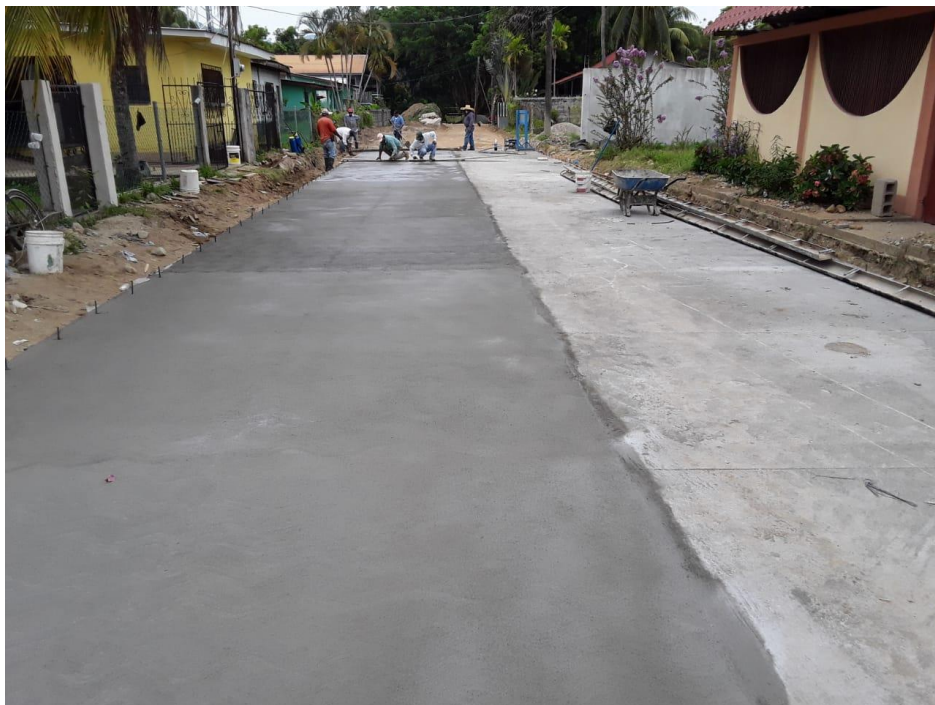
Ilustracion2. Fundición de losa de pavimento terminada 30 metros lineales.
