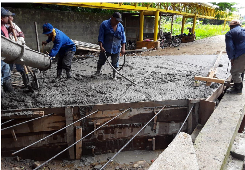
Ilustracion1. Fundición de losa de puente #1
