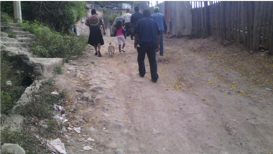
Vista panorámica de la continuación de la pavimentación
