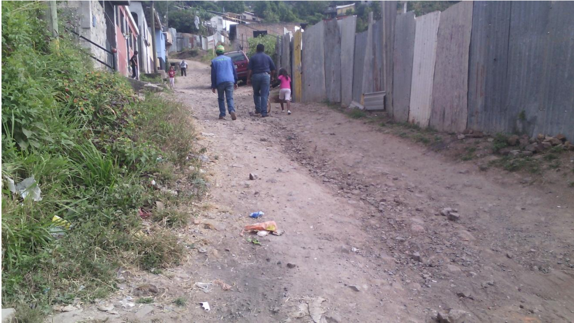
Vista de la continuidad de la calle a pavimentar
