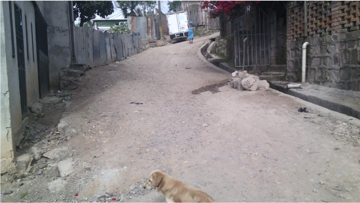
Inicio de la calle a pavimentar
