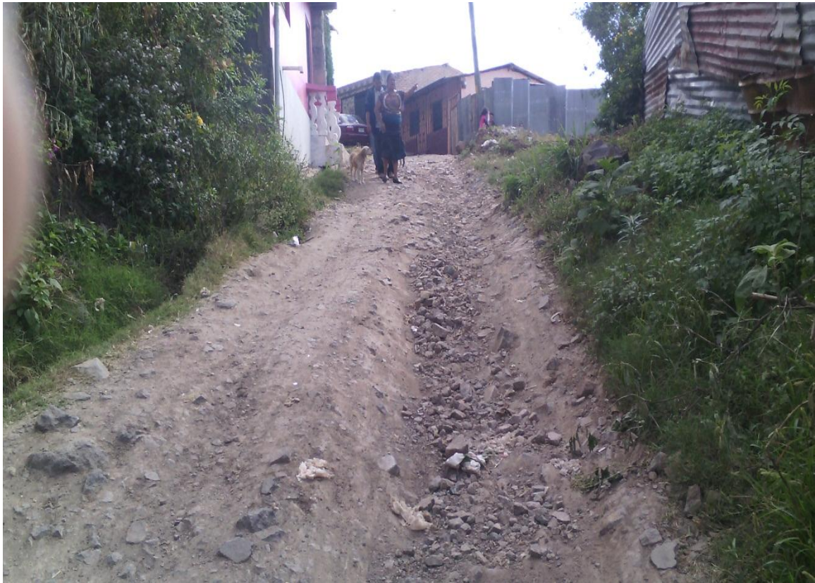
Final de calle a pavimentar
