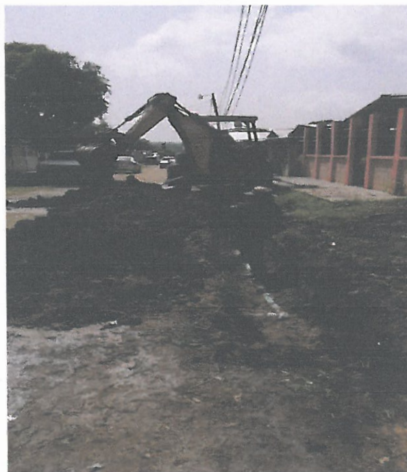
Trabajo de cambio de tuberías en Col. Villa Linda Norte sector Sur Este por problemas de suministro de agua.
