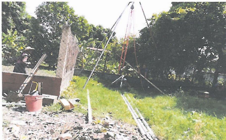
Mantenimiento de la bomba de agua potable en Barrio La Victoria sector Esta A por parte de la municipalidad.
