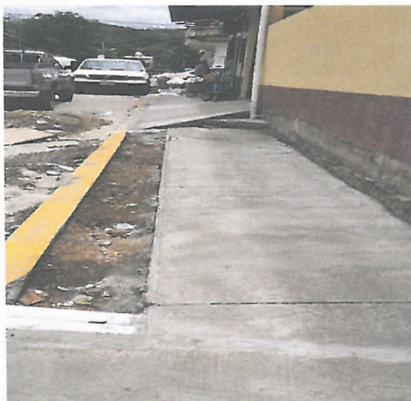
Avances del proyecto de aceras peatonales en Barrio Francisco Morazán sector Oeste A, con apoyo de la municipalidad.
