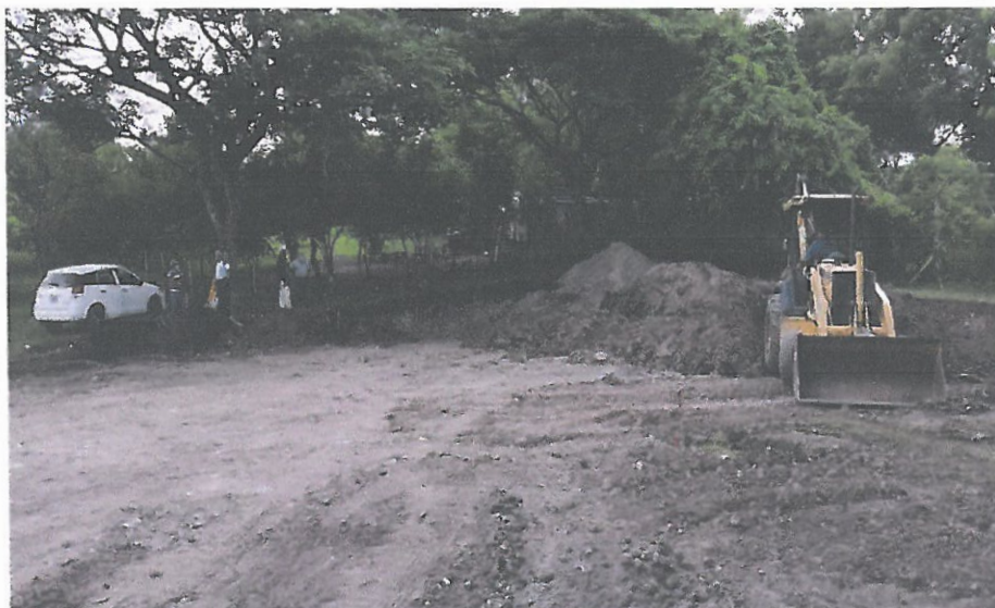
Preparación de terreno para construcción del Centro de Salud de la Col. kilómetro 86 por parte de la municipalidad.
