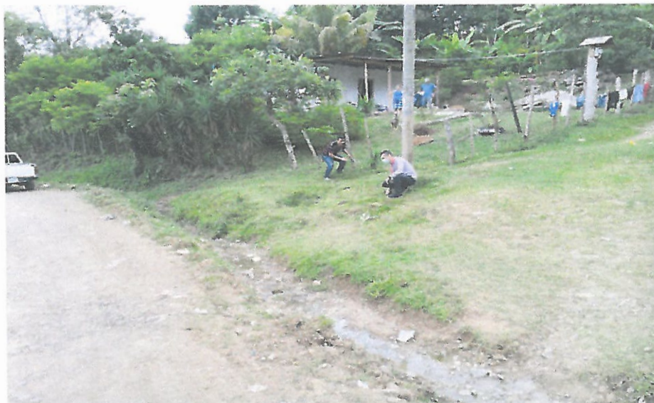
Evaluación de proyecto de cajas de paso en Aldea San Isidro sector Venado por parte de la municipalidad.
