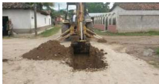
Realización de Calicatas Alcantarillado Sanitario de Casco Urbano de Sensenti.
