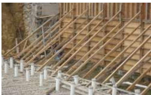
Vibrado exterior para ilimitación de espacios vacíos en vertido de concreto
