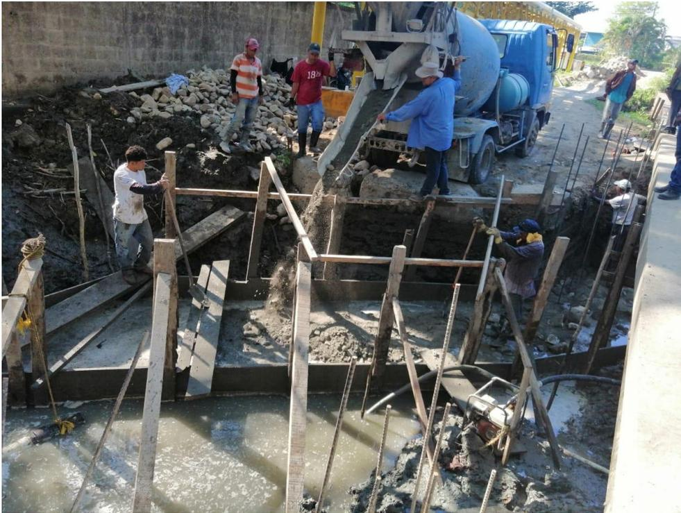
Ilustracion4. Fundición de cabezal del primer puente hacia cancha de golf.
