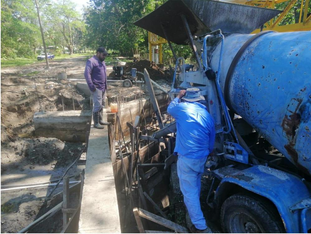
Ilustracion3. Fundición de cabezales del primer puente hacia cancha de golf.
