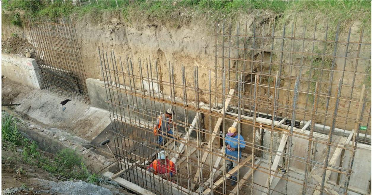
Armado de refuerzo de hierro en losa y paredes de pasos vehicular.
