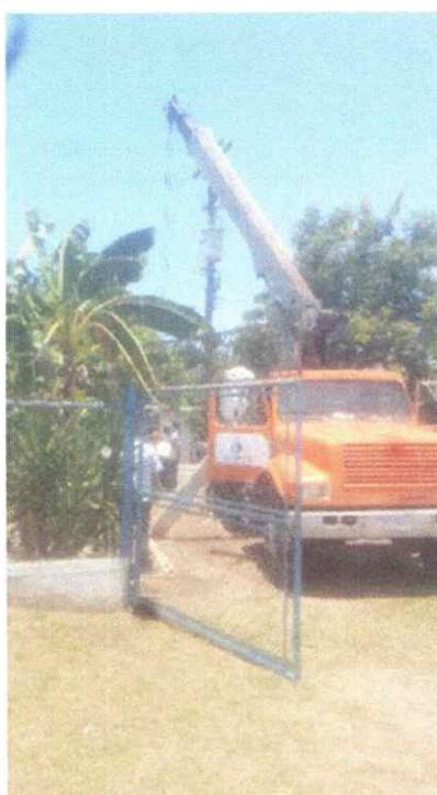
11. Mantenimiento general en pozo Gran villa #2 inspección con cámara, medición con sonda sónica, aplicación de químicos, sopleteo y aforo.
