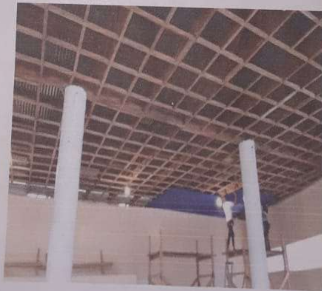
INSTALACION Y DEMOLICION DE CIELO FALSO
