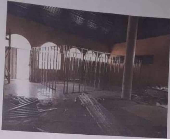
ARMADO DE PAREDES
