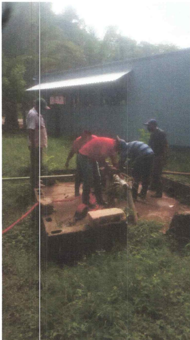
17.Reparación de tubería de impulsión de 6" en la Colonia Orquídea 3.
