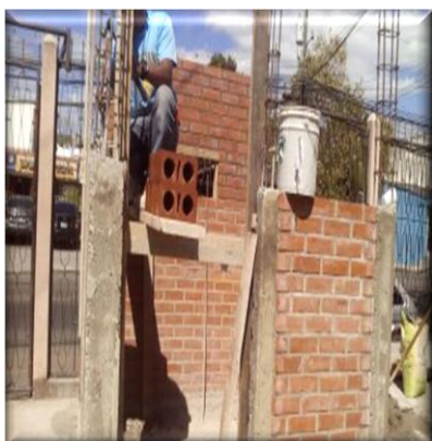
Construcción de casetas
