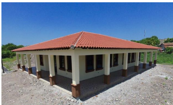
Edificio de la Biblioteca CURNAC
