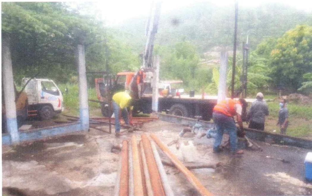
6. Reparación de tubería de 6" en El Marañón.
