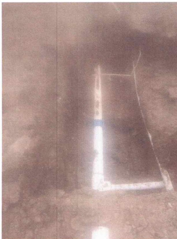
11. Reparación de tubería de 6" frente al Pozo N° 4.
