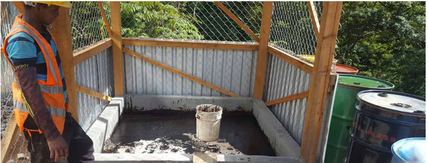
PDABR. Construcción de muro para contención de materiales peligrosos.
