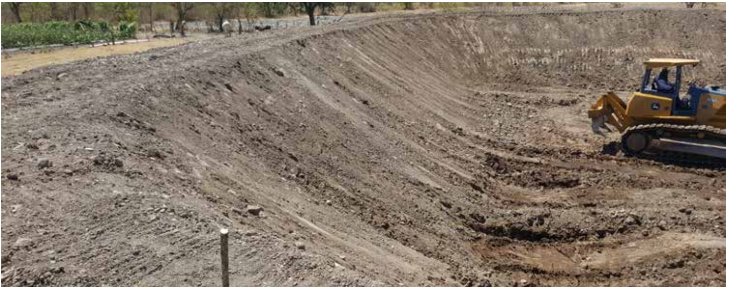
SAG-EMPRENDESUR. Construcción de cosechadora de agua en la comunidad de Tapaire, Choluteca.
