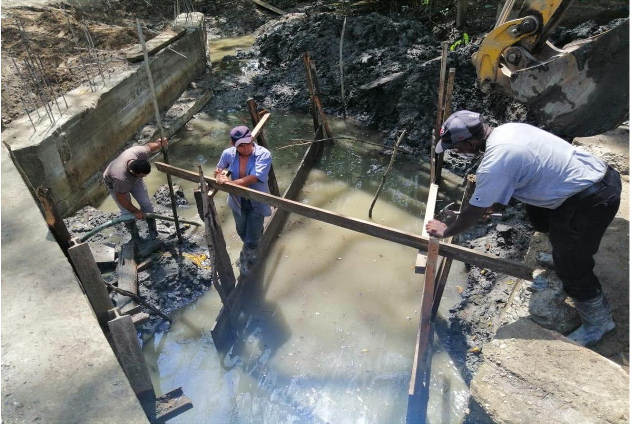
**CABEZAL SUR FUNDIDO Y ENCOFRADO DE CABEZAL NORTE**
