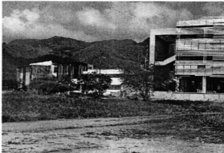
Avances en Edificio Aulas No.1 , fachada sur
