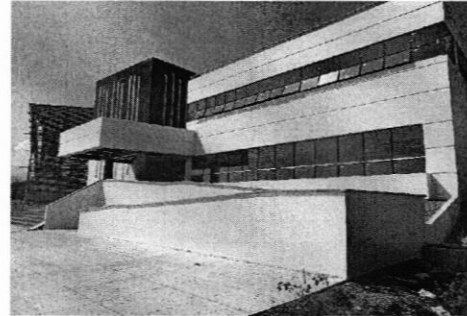
Avances fachada sur, edificio administrativo, aplicación de pintura.
