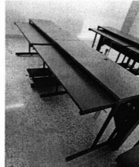
Intalacion de muebles en aulas 1er nivel, Edificio Aulas No.1
