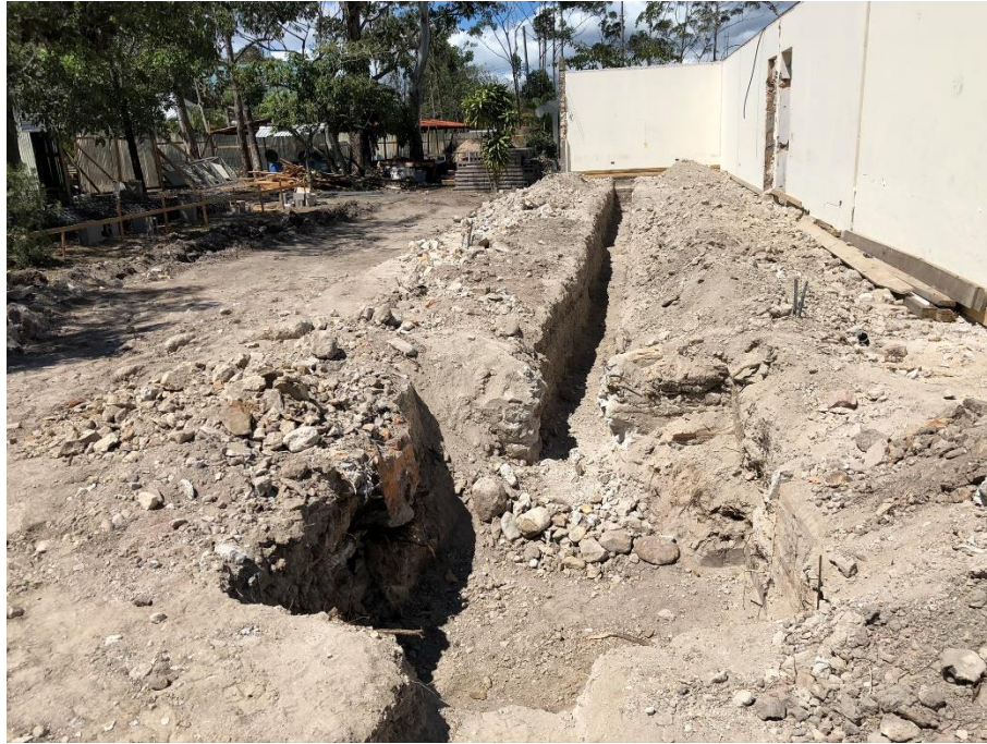
Imagen 4. Excavación de Zapatas Aisladas
