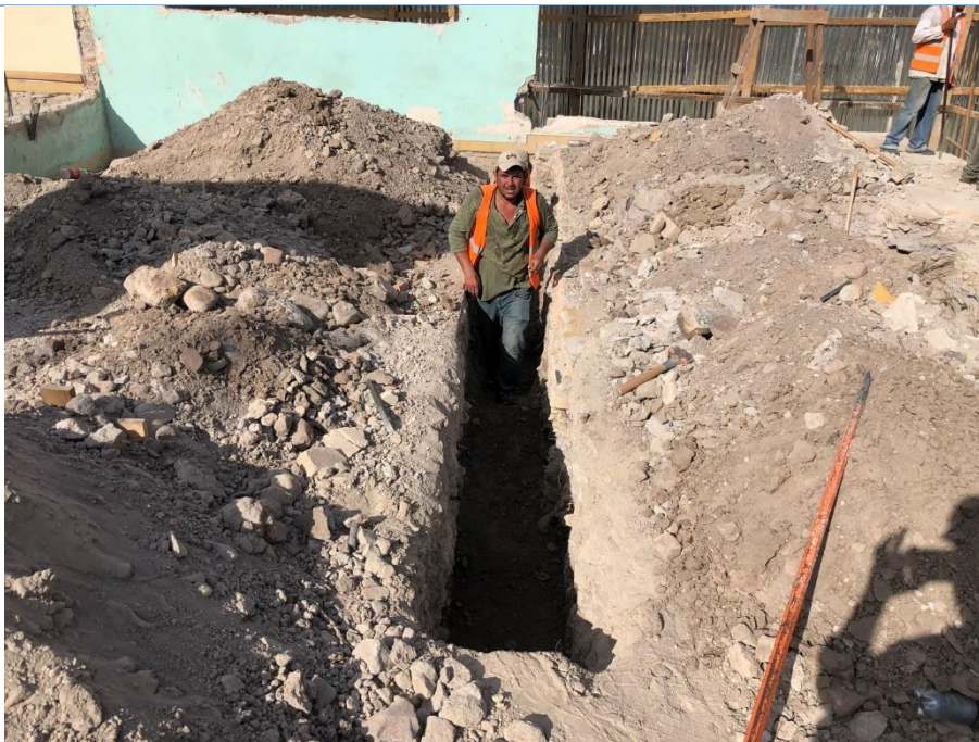
Imagen 3. Excavación de Zapatas Corridas
