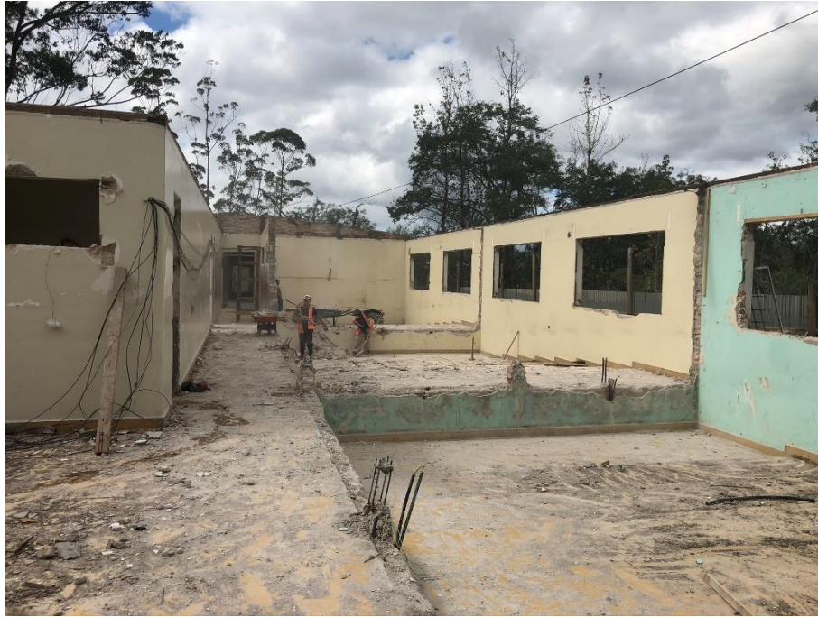
Imagen 1. Demolición de Paredes MIII
