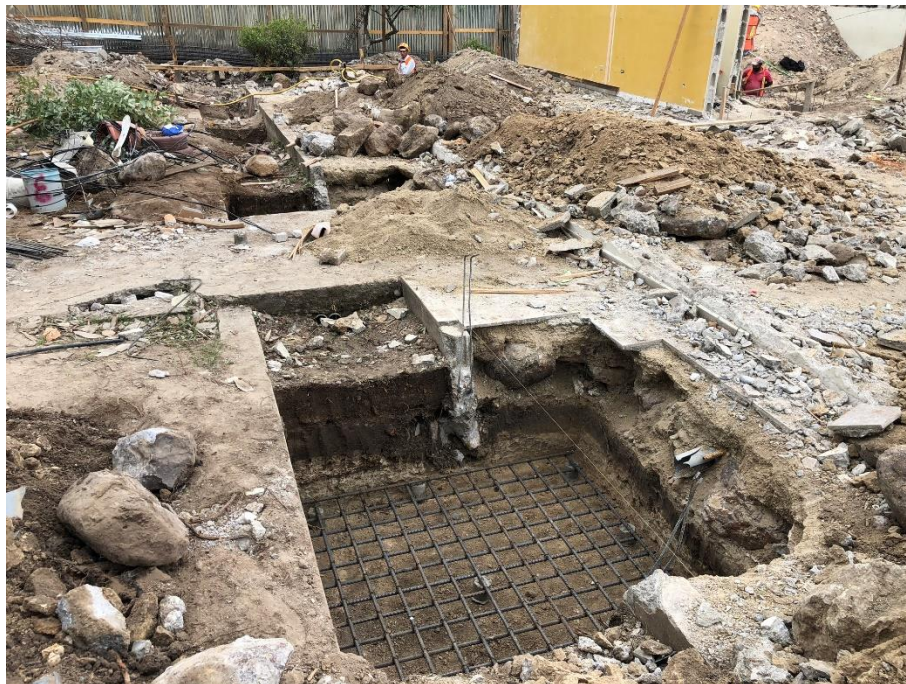
Imagen 8. Armado de Zapatas Aisladas
