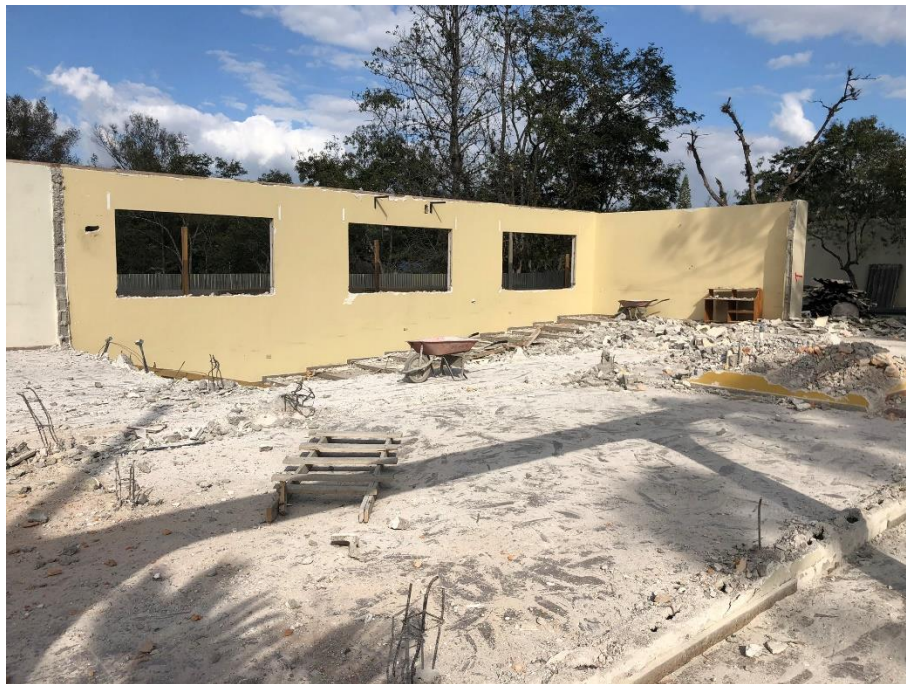
Imagen 2. Demolición de Paredes MII
