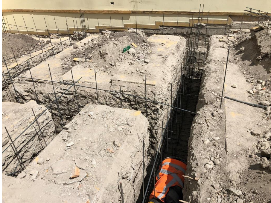
Imagen 7. Armado de Zapatas Corridas
