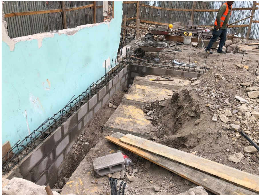
Imagen 5. Relleno de Material Selecto
