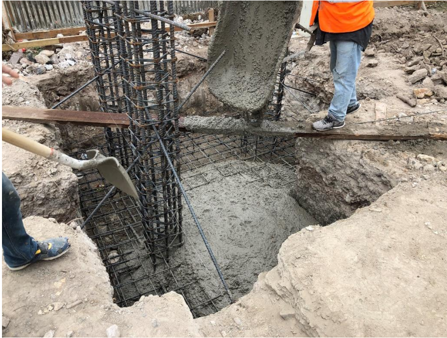
Imagen 9. Fundición de Zapatas Aisladas
