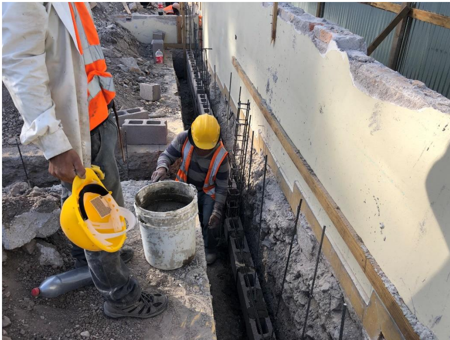
Imagen 10. Sobrecimentación de Bloque
