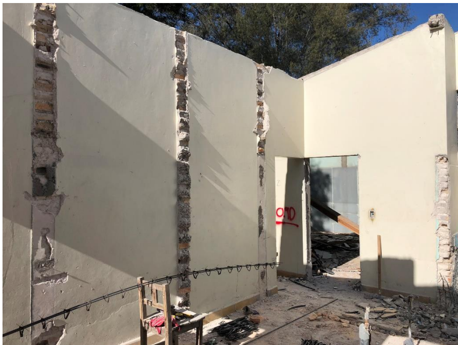
Imagen 3. Demolición de Paredes
