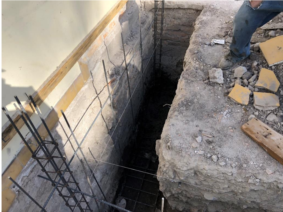
Imagen 7. Fundición de Zapatas
