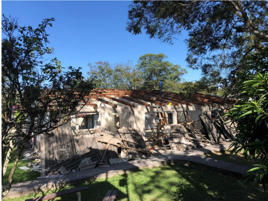
Imagen 2. Desmontaje de Techo y Cielo
