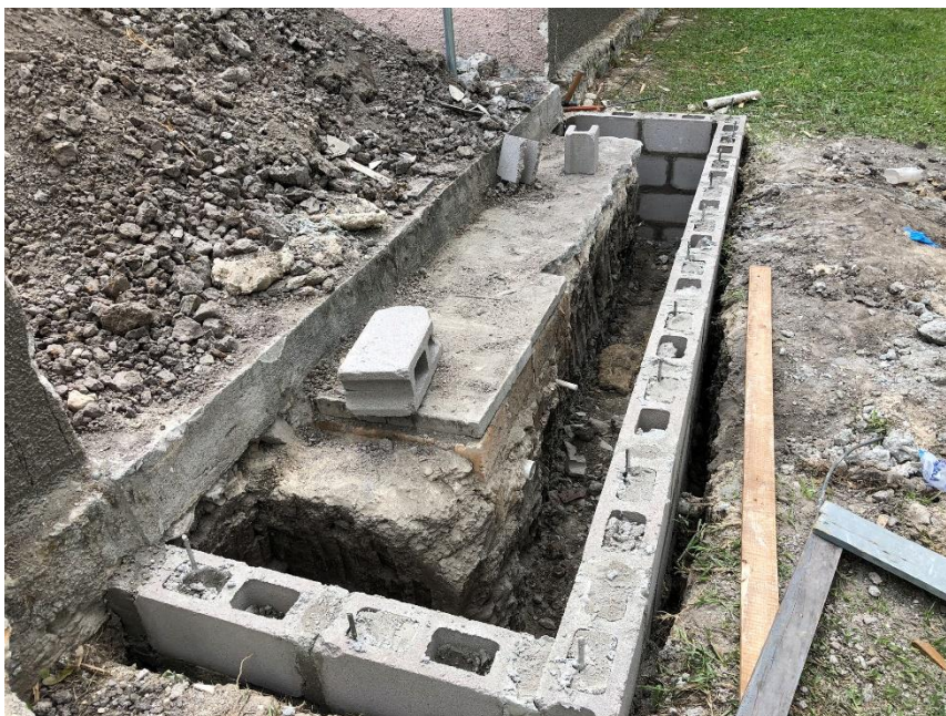
Imagen 8. Sobre cimentación de Bloque
