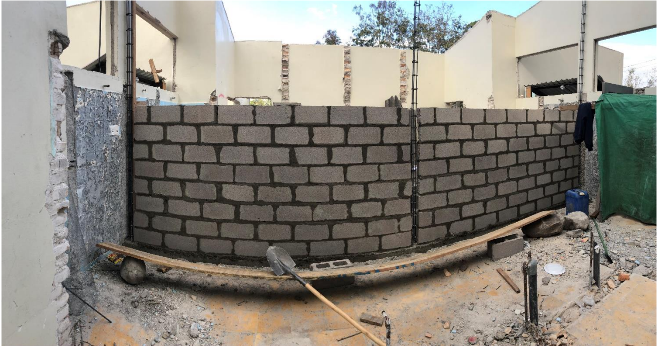
Imagen 10. Pared de Bloque Interiores
