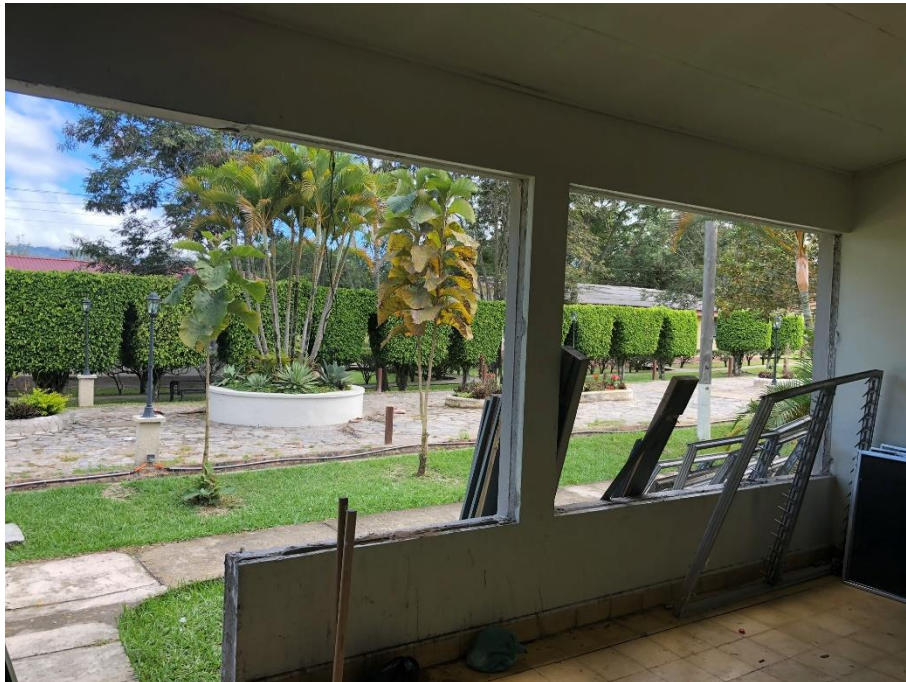
Imagen 1. Desmontaje de Puertas y Ventanas
