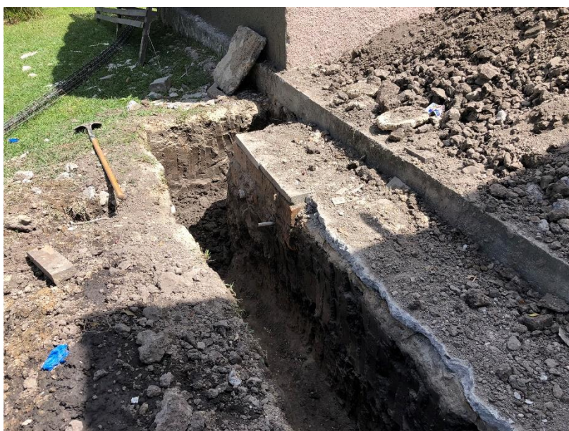
Imagen 5. Excavación para Cimiento
