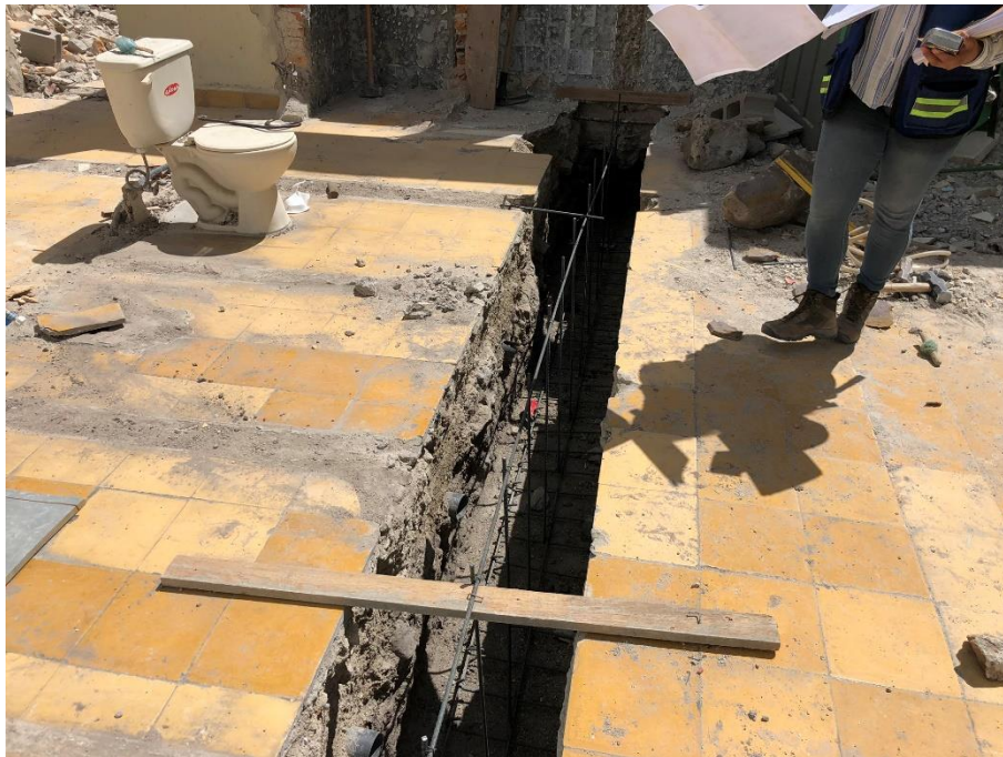
Imagen 6. Armado de Zapatas
