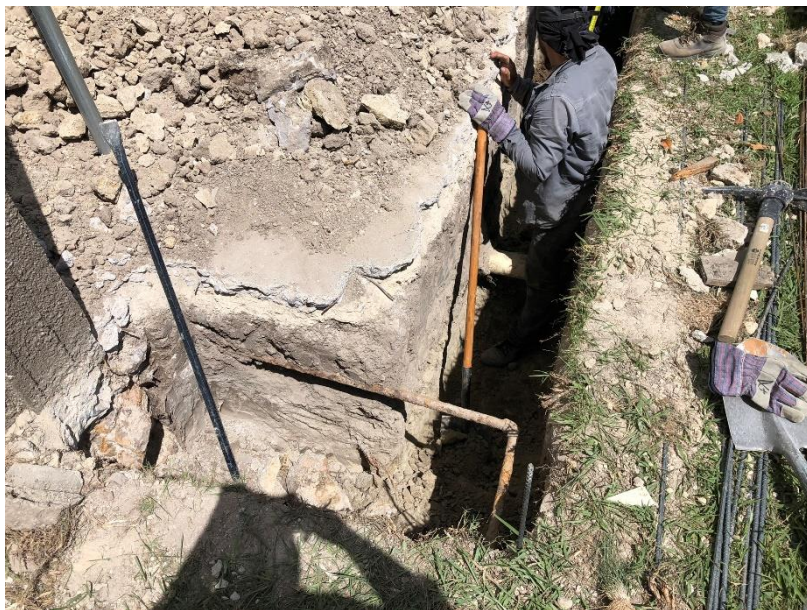
Imagen 4. Excavación para Cimientos
