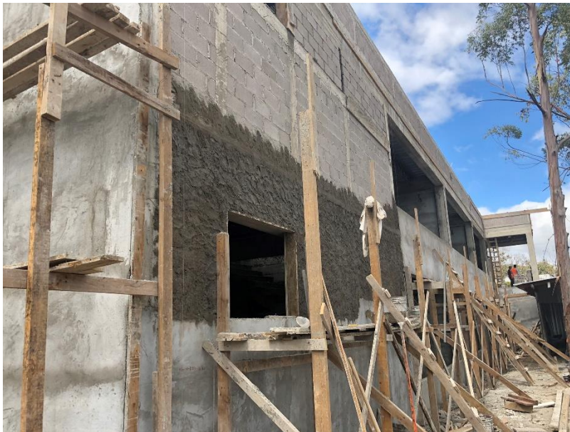
Imagen 6. Repello Exterior
