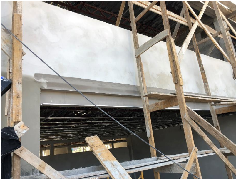
Imagen 3. Instalación de Fascias de Durock en exteriores.
