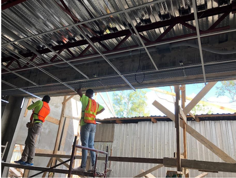
Imagen 2. Instalación de Fascias en Ventanas
