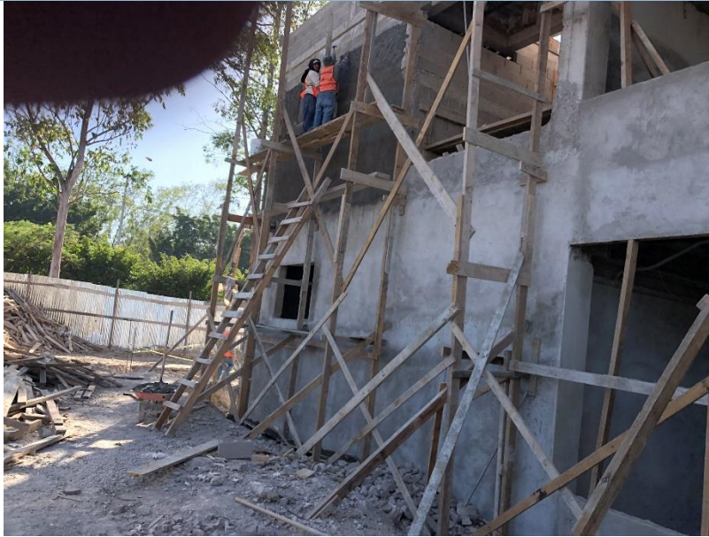
Imagen 7. Repello Exterior
