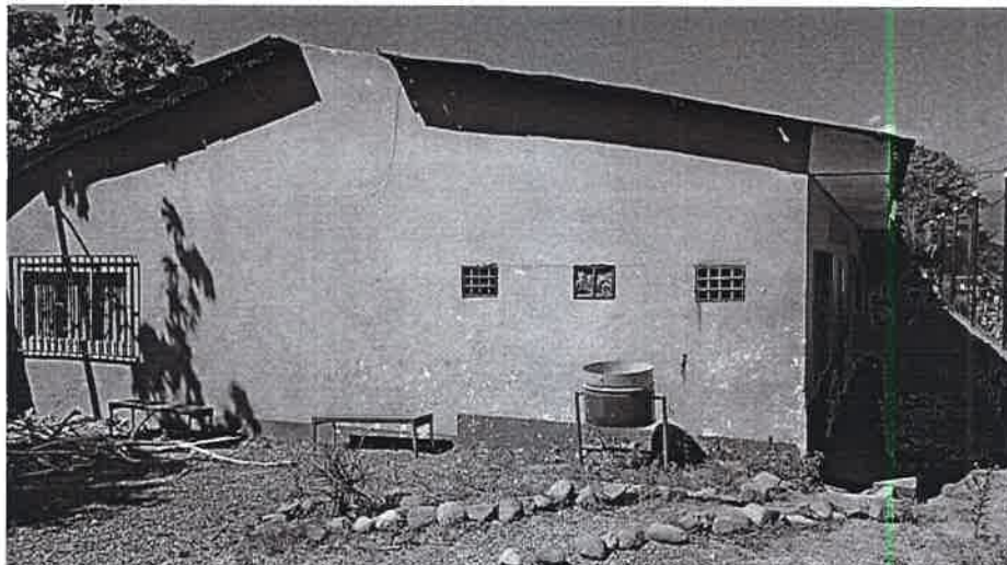
Mejoramiento de Kínder Carlos Miranda, en el Bo. Suyapa, en esta Ciudad de Comayagua.
