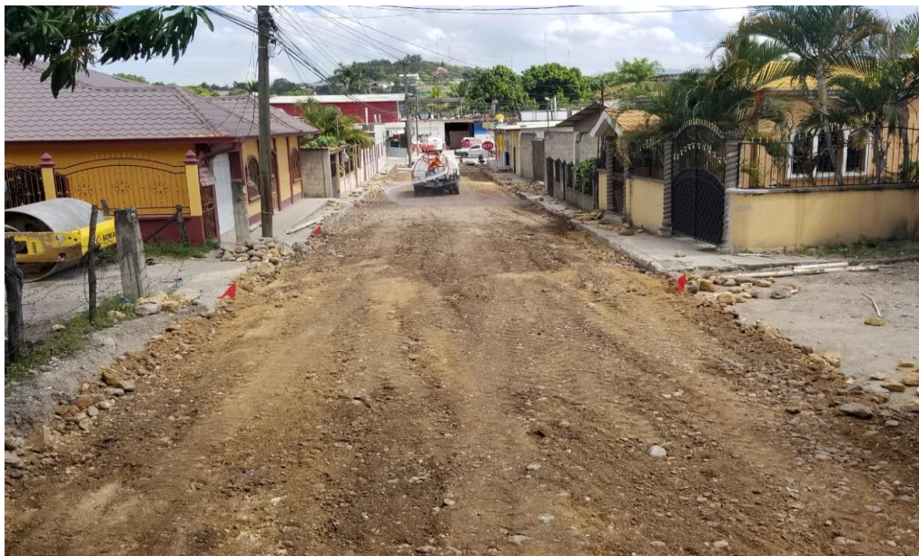
Trabajos de terracería en colonia Vanessa Limpia de Calles y tendido de material selecto para vibrar.
