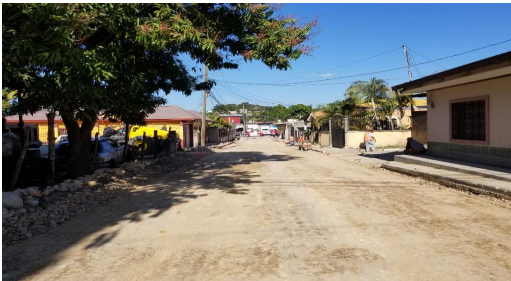
Se visualiza la calle en su acabado con su rasante terminada
