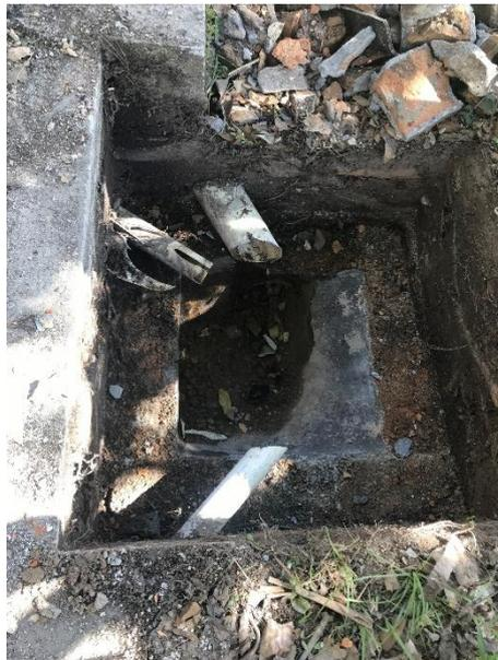
**e. CORTE Y DEMOLICIÓN DE FIRME DE CONCRETO**
