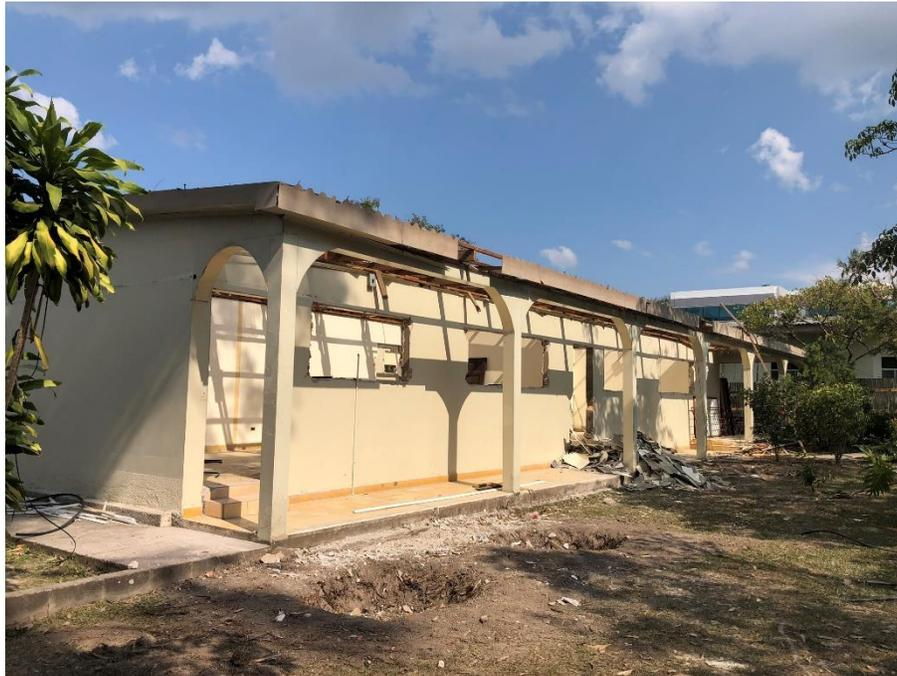
*Imagen 6. Desmontaje de Techo y Cielo Falso*
