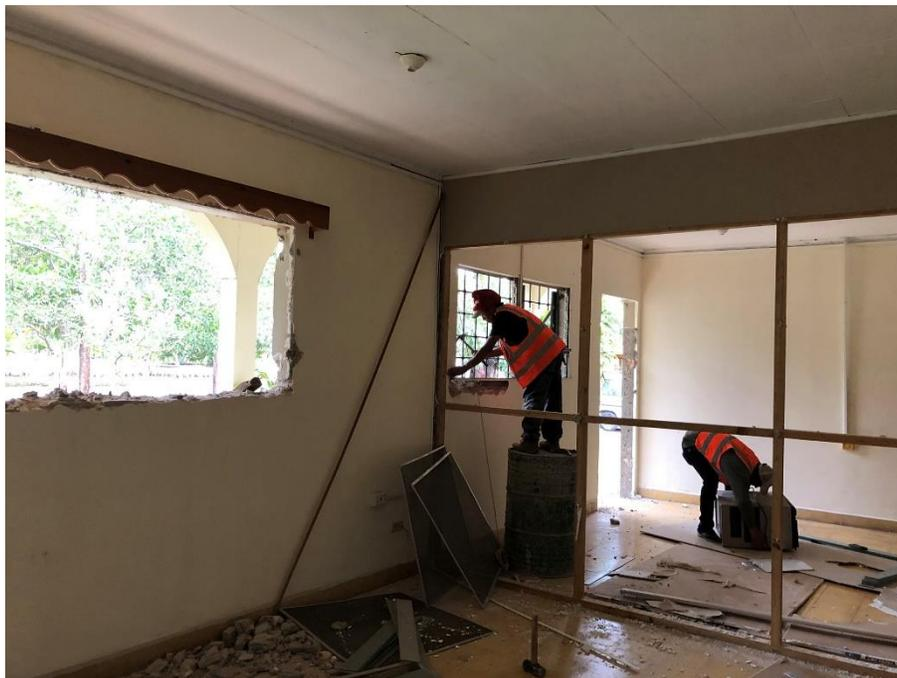
*Imagen 6. Desmontaje de Paredes de Tablayeso*
