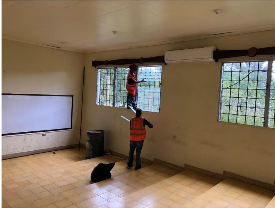
*Imagen 5. Desmontaje de Ventanas*
