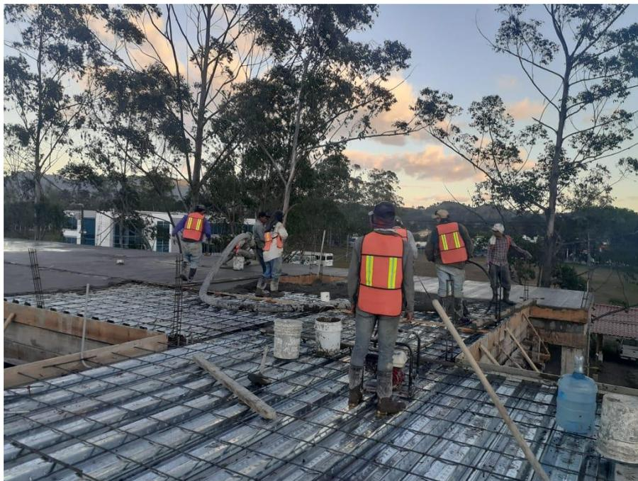
*Imagen 4. Fundición de Losa*
