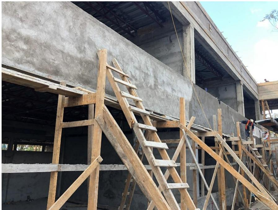
Imagen 16. Repello de Paredes Exteriores
