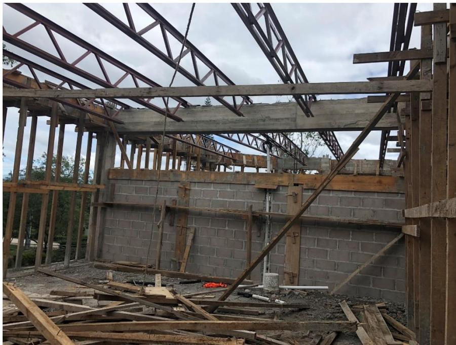
*Imagen 2. Instalación de Joist*
