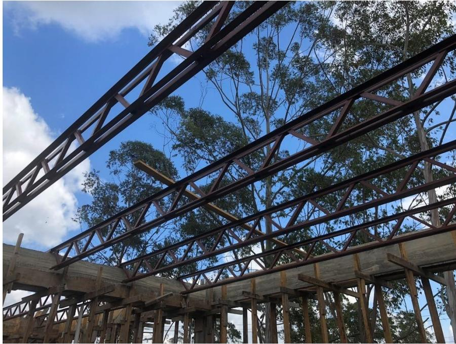
*Imagen 1. Instalación de Joist*
