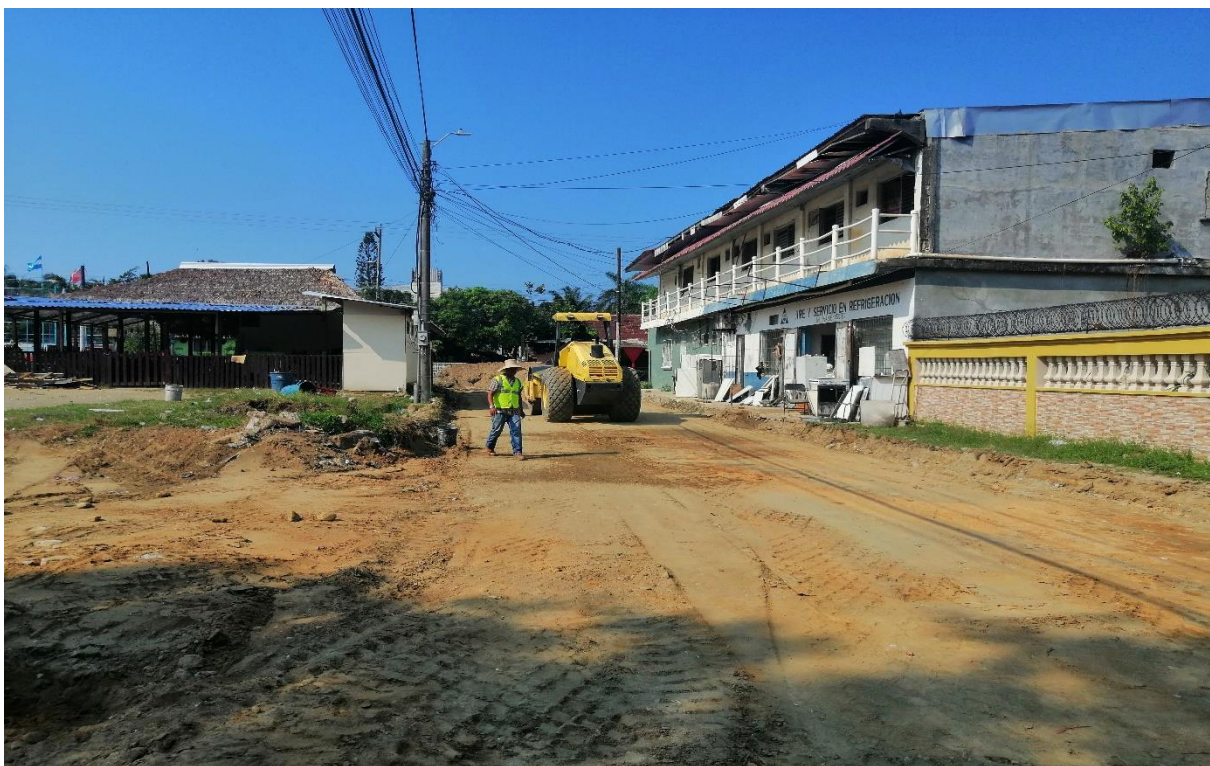
CONFORMACION DE TERRENO PARA PAVIMENTO
