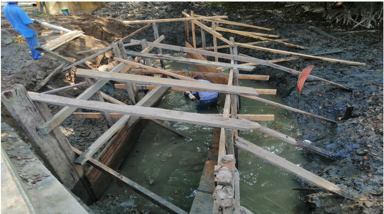
ENCOFRADO DE CABEZAL DE CAJA PUENTE,
