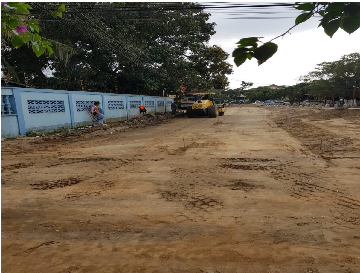
COMPACTACION DE TERRENO PARA PAVIMENTO
