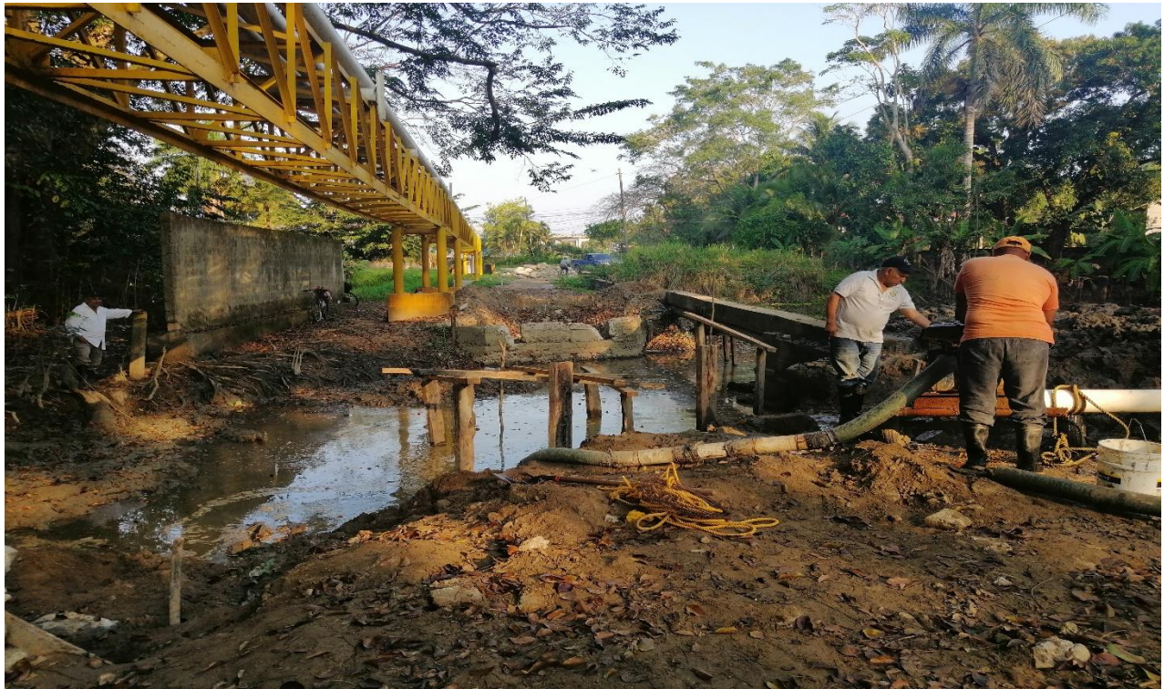
ACHICADO DE AGUA PARA COLOCACION DE ACHICADO
