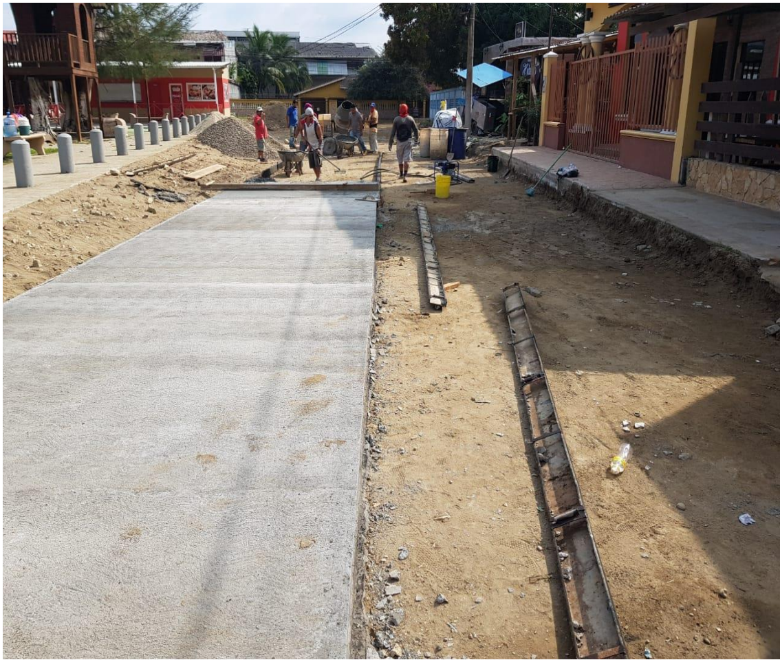
FUNDICION DE CONCRETO HIDRAHULICO
