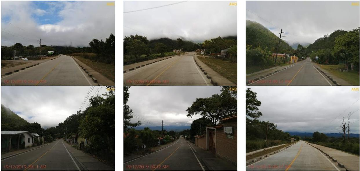
Como puede observarse, la calzada se encuentra en buen estado, al igual que los sistemas de drenaje, con excepción del problema de la alcantarilla deliberadamente bloqueada por un particular, haciendo que las aguas corran por la cuneta. Existe un agrietamiento en el km 4+800, que se monitorea periódicamente, sin embargo, permanece estable; no se puede considerar como falla.
